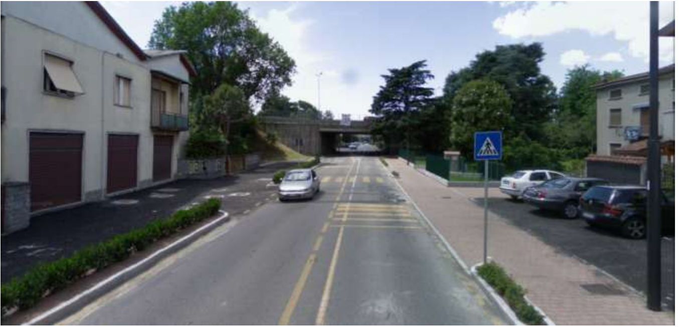
(3) Sottopasso Milano – Meda di corso Isonzo all’altezza del civico n. 150, località Dossi – Baruccana
