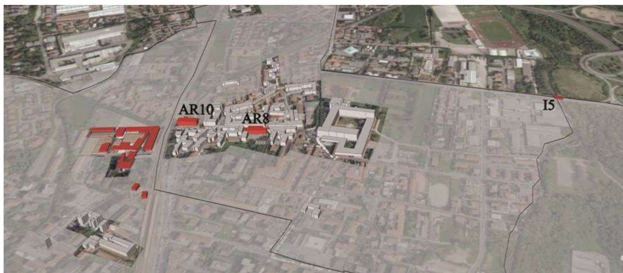
In località San Pietro Martire compaiono due case padronali e il ponte sulla Certesa.
