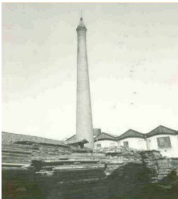
Il caminone dello Stabilimento Marzorati a San Pietro
