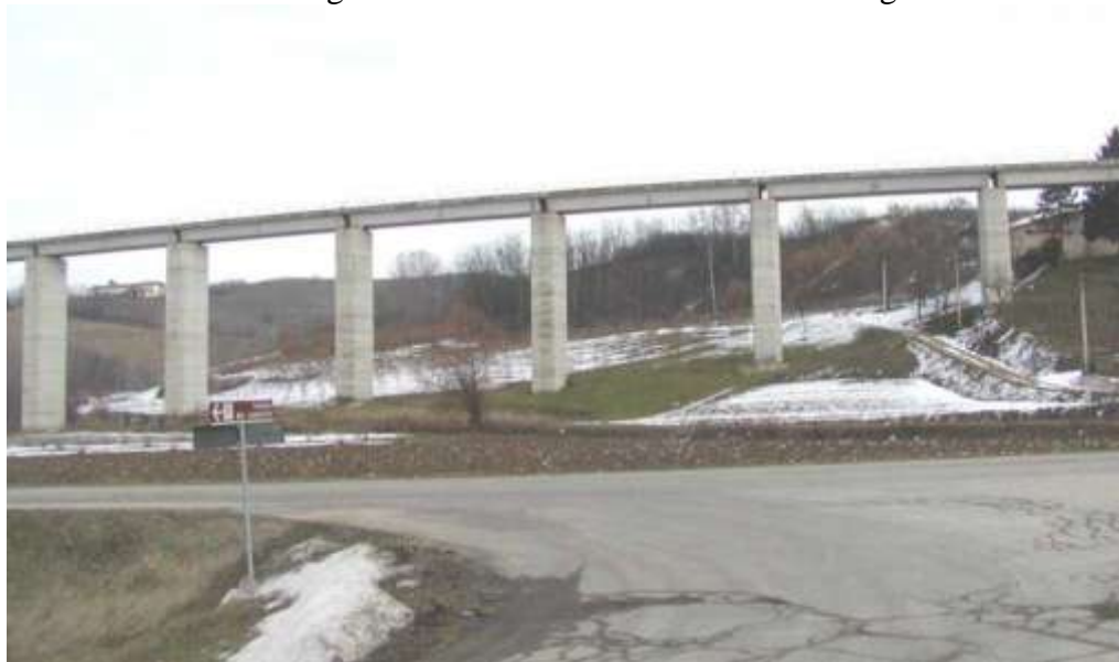
Stato di fatto - Cavalcavia ferroviario Castagnole Lanze (AT)
