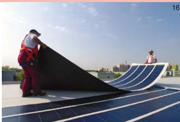
Foto 16: La nuova soluzione dei pannelli flessibili a pellicola sottile rispetta gli standard dei sistemi fotovoltaici BIPV (ad integrazione architettonica) ed è stata concepita al fine di soddisfare sia le esigenze energetiche che di copertura di grandi tetti industriali a basso limite di carico.
