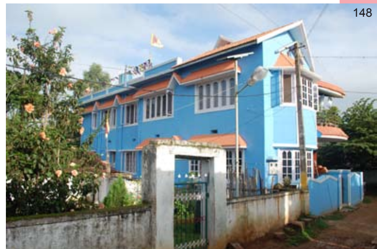
foto 148: Vimala house è stata terminata due anni fa. Si tratta di una casa a due piani con una terrazza con vista sul campo numero 5 e su tutta la campagna intorno
