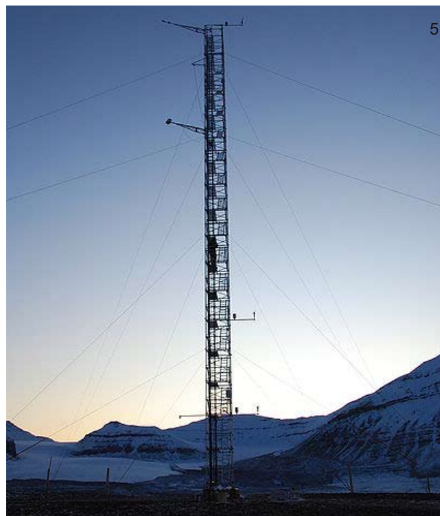
foto 5: Amundsen-Nobile Climate Change Tower, Kolhaugen (Polo Nord): E' un progetto italiano di CNR Polarnet attivo da giugno 2009; si tratta di una torre alta 34 metri che mostra in tempo reale la differenza tra le temperature raccolte al suolo con quelle registrate a 34 m di altezza, con l'obiettivo di studiare i delicati cambiamenti del clima.
