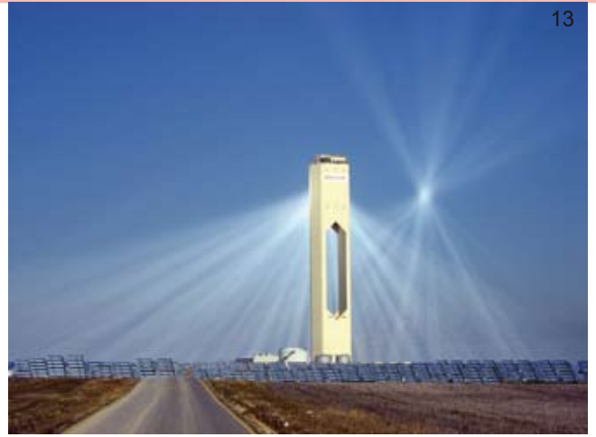
foto 13: Plataforma Solucar, Siviglia: la vetrina più spettacolare per il futuro delle energia solare. La torre da 11 megawatt chiamata PS-10 è circondata da 624 specchi che seguono il percorso del sole e ne riflettono i raggi sulla sommità, dove viene prodotto vapore per azionare una turbina producendo 4 megawatt per mq. Accanto è stata costruita PS-20, con un numero quasi doppio di specchi e una capacità doppia di produzione.
