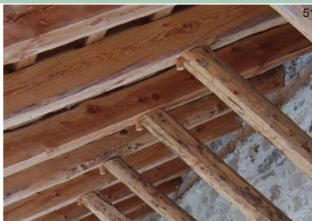
foto 51: struttura con copertura a incastro centrale
