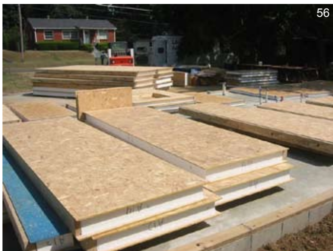
foto 56: fase di montaggio di un abitato che utilizza i pannelli SIP; foto 57: l' X- panel di Stratex, azienda di Udine leader nel settore delle costruzioni in legno prefabbricato, è un pannello autoportante che ha anche una versione ecologica in cui viene impiegato come strato isolante un pannello in fibre di legno, più o meno spesso, a seconda della fascia climatica del sito
