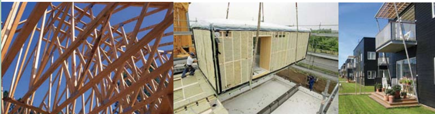
foto 103-105: immagini di casa Boklok in diversi momenti di costruzione
