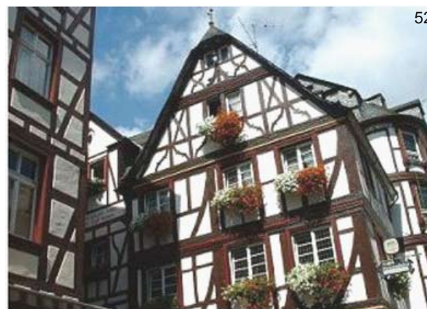
foto 52: tipica Fachwerk con tamponamenti in muratura
