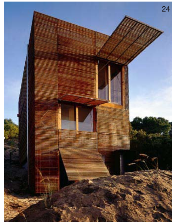
foto 24: Casa unifamiliare di Sean Godsell, Victoria, Australia, 2000: è un esempio di schermatura mobile orizzontale in facciata utilizza che permette all'edificio di adattarsi alle diverse condizioni climatiche e stagionali massimizzando il guadagno termico delle superfici vetrate.
