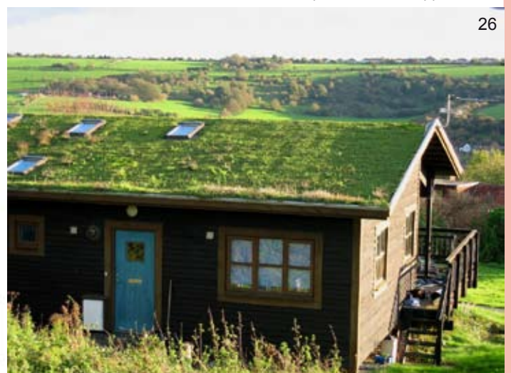
foto 25-26: stratificazione di un tetto di tipo estensivo e applicazione
