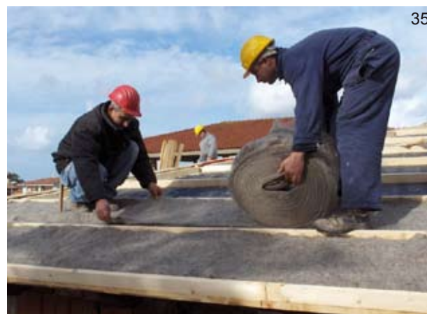
foto 35: l'azienda sarda Edilana rappresenta un perfetto esempio di come i materiali naturali possano sostituire quelli tradizionali in modo ottimale; l'azienda realizza coperture in pura lana vergine di pecora sarda autoctona, per l'isolamento termico e acustico e la regolazione igrometrica dell'ambiente. E' indicato per l'isolamento di tetti ventilati e non ventilati, murature perimetrali, murature interne, solai, controsoffitti, per l'isolamento e il riempimento delle intercapedini del telaio di finestre e porte
