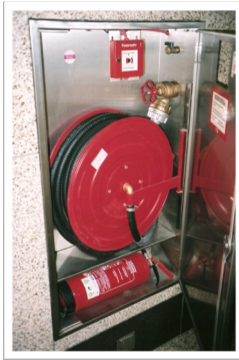
Fig. n.1 – Cassetta antincendio UNI con idrante ed estintore
