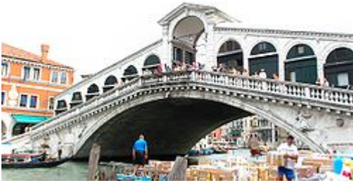
F7. Ponte di Rialto
