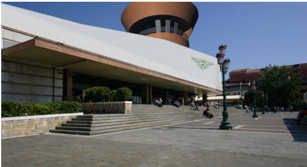
F133. Stazione ferroviaria di Santa Lucia dopo l'innesto della funivia
