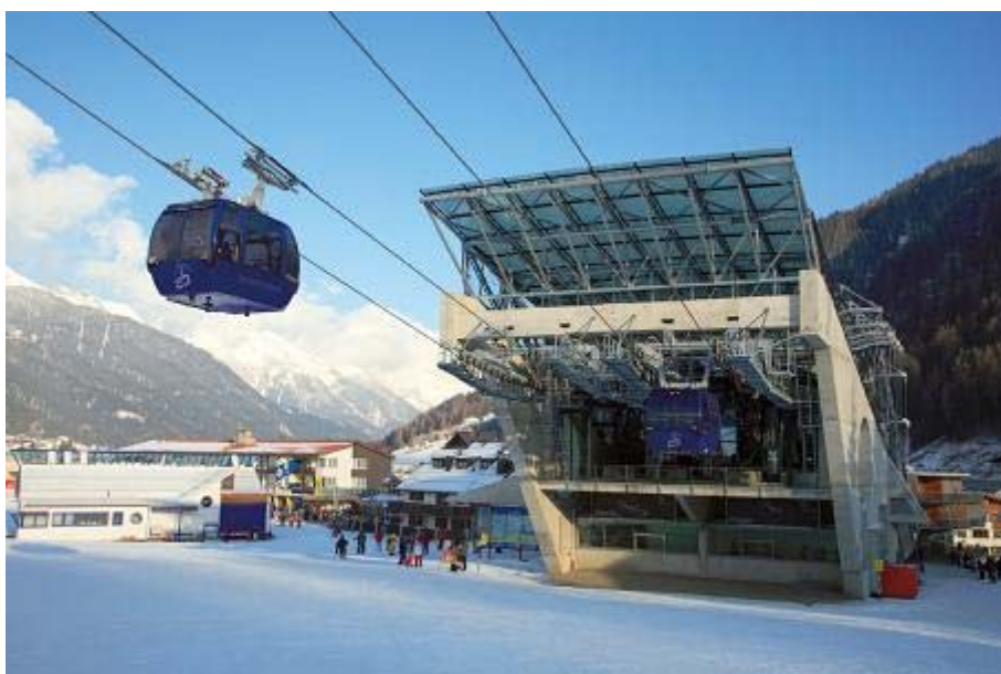
F121. Galzigbahn. Stazione motrice di valle
