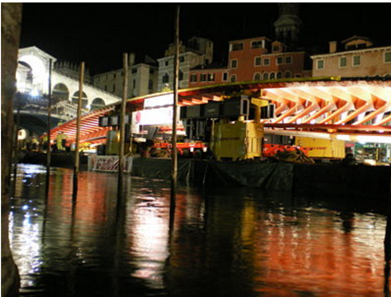
F11. Il passaggio del concio centrale sotto al Ponte di Rialto alla mezzanotte dell'8 agosto 2007.
