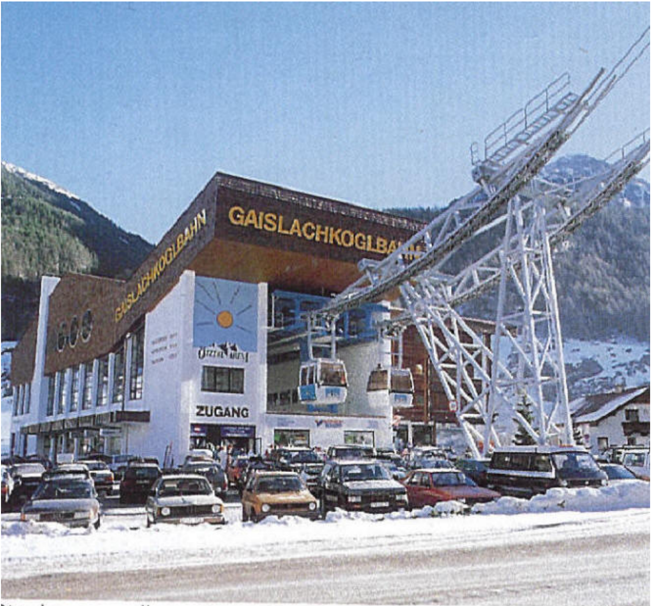
F60. Stazione di valle dell'impianto di Soelden, Austria
