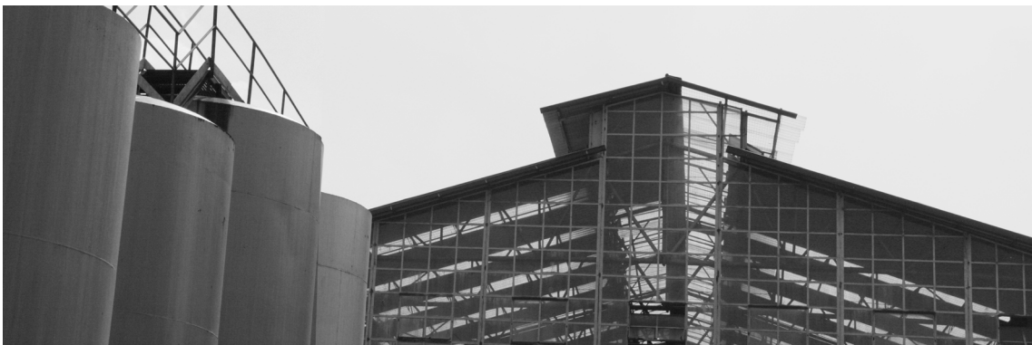
23. Sopralluogo all'area di progetto
