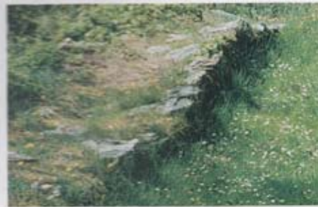
32. Esempio di muratura detta "a sacco". In questo caso vengono realizzati due muri affiancati e al loro interno vengono gettate scaglie di pietra. Queste strutture sono particolarmente resistenti.
