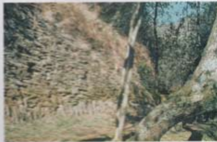
30. La zona basamentale del muro è realizzata con pietre disposte verticalmente. Questa tecnica viene realizzata per facilitare l'espulsione delle concentrazioni d'acqua.
