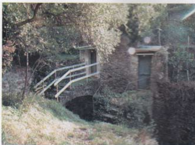
15. Costruzioni realizzate in pietra a secco per il riparo degli attrezzi presso alcuni limoneti. Per la coltura dei limoni è necessario creare delle strutture che permettano di proteggere dal vento e dal freddo le piante. I limoneti che sorgono lungo un torrente sono resi accessibili dall'uso di alcuni ponti. In prossimità dell'accesso al limoneto, al termine del piccolo ponte, vengono realizzati anche dei ripari per gli attrezzi più importanti. Le ringhiere che si vedono nella foto sono state aggiunte in un secondo momento.
