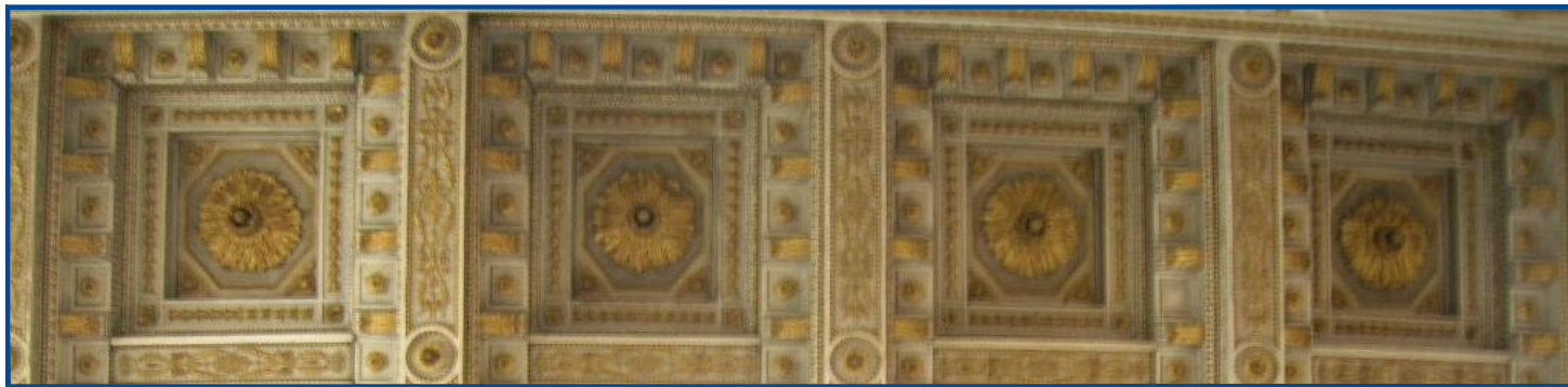
177. Particolare della copertura a cassettoni della navata centrale
