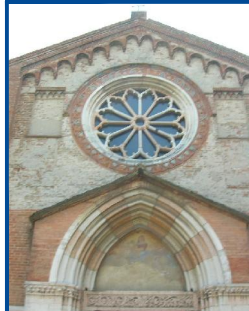
240. Chiesa di Santa Maria del Gradaro, rosone
