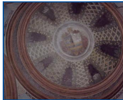
45. Cappella del Mantegna, copertura
