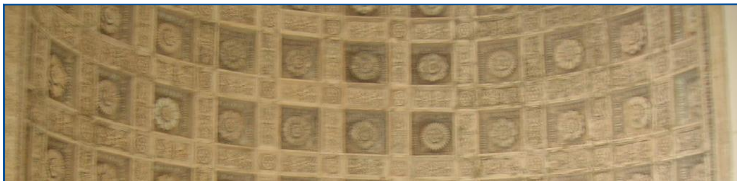
56. Particolare dei cassettoni della copertura a volta a botte della navata centrale
