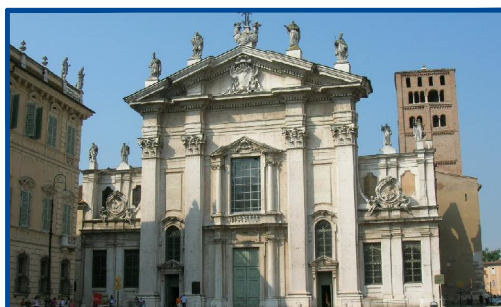
159. Facciata e campanile
