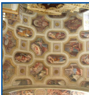
171. Copertura a volta a botte del transetto
