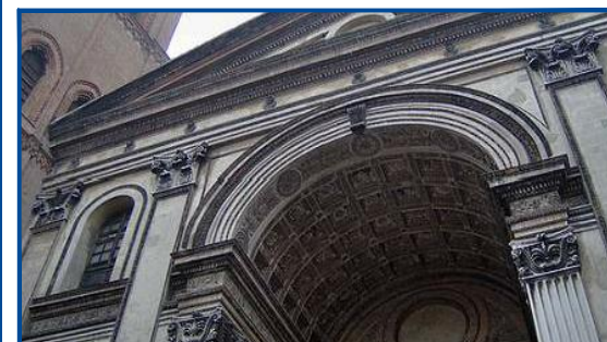
61. Volta esterna d'ingresso
