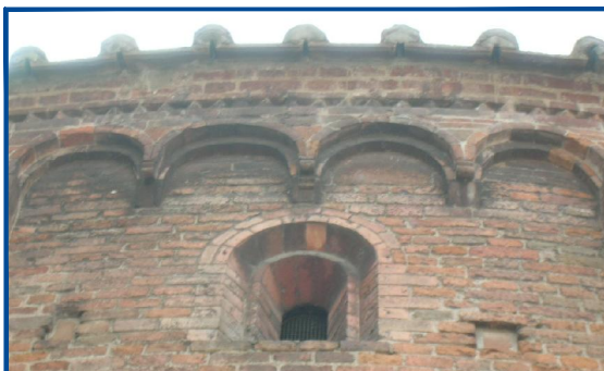
111. Particolare del coronamento della facciata
