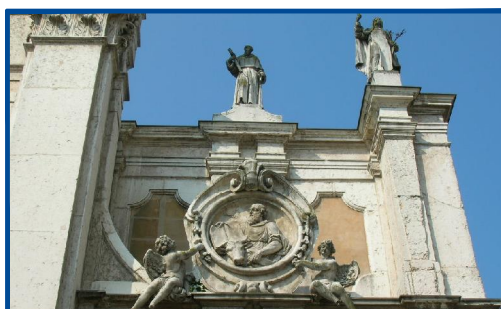
162. Complesso statuario in facciata
