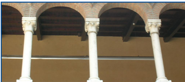
399. Particolare della loggia sul chiostro interno
