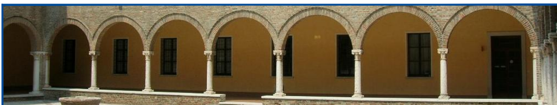
394. Particolare di un lato del chiostro interno
