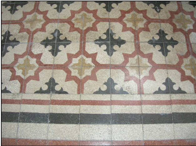
307. Quingentole, Chiesa di San Lorenzo, particolare della pavimentazione
