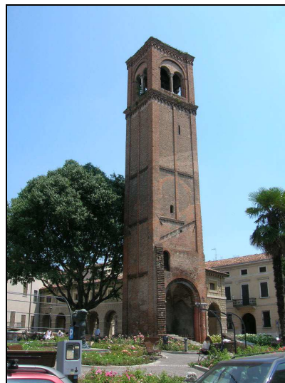
297. Mantova, Torre di San Domenico
