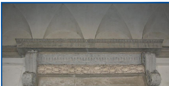
439. Architrave del portale d'ingresso
