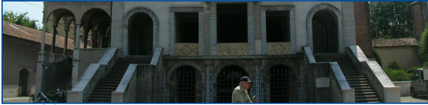
468. Ingresso alla cripta
