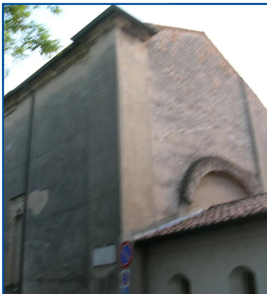
524 Esterno della zona absidale
