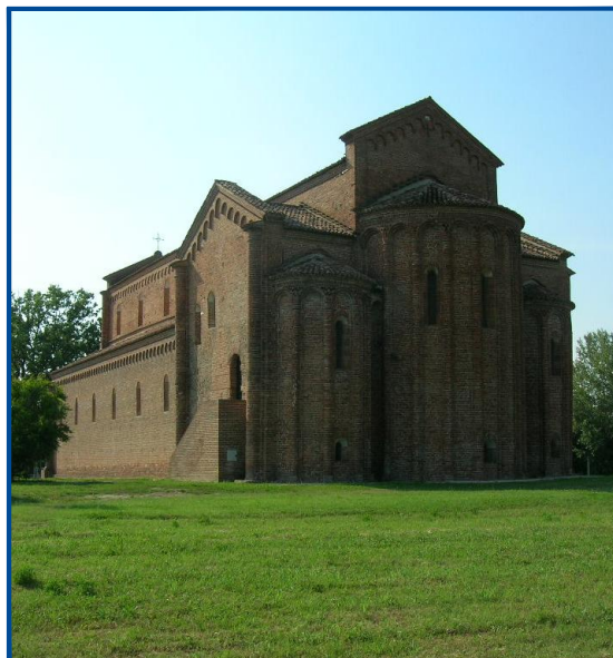
596. Esterno della zona absidale
