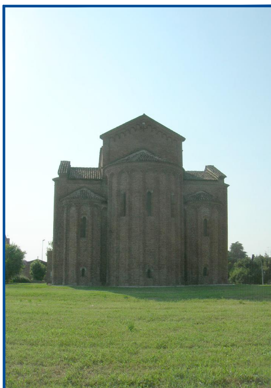
594. Esterno della zona absidale
