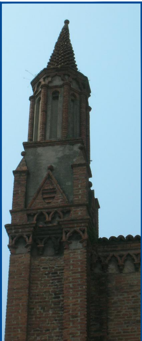
604. Pinnacolo sulla facciata verso via Scarsellini
