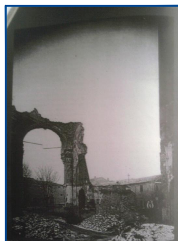
611. Resti dell'abside dopo il bombardamento del 4 aprile 1945
