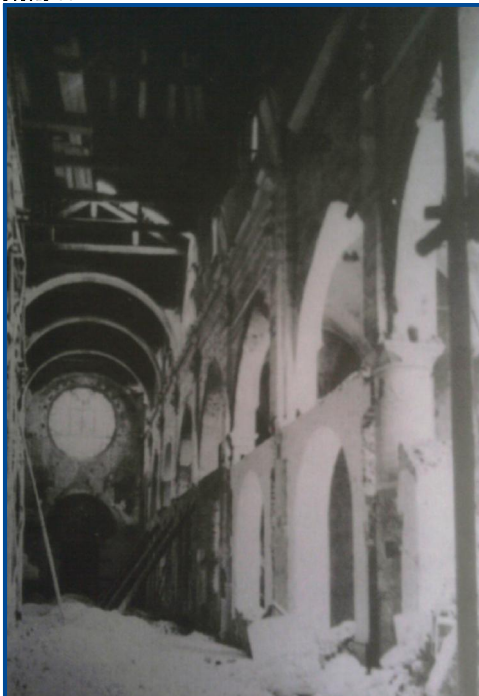
607. La chiesa dopo il bombardamento del 3 e dell'8 agosto 1944
