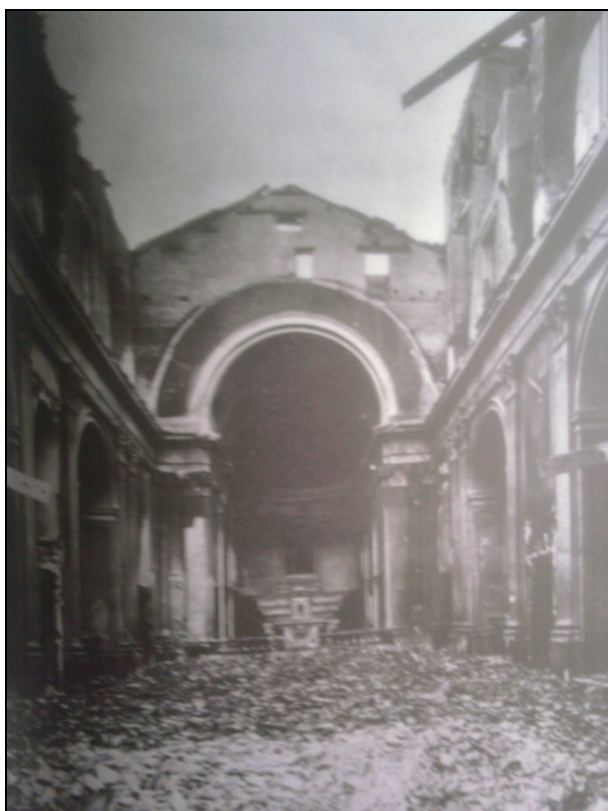
591. Mantova, Chiesa di San Leonardo: macerie dovute ai bombardamenti del 14 luglio 1944
