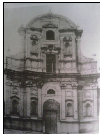
595: Mantova, Chiesa dei Filippini prima dei bombardamenti
