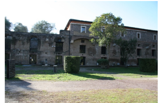
Figura 23 Vista del fronta dell'Antiquarium
