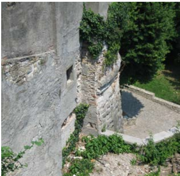
Interventi di ricostruzione muraria accanto al torrione Castagneta
