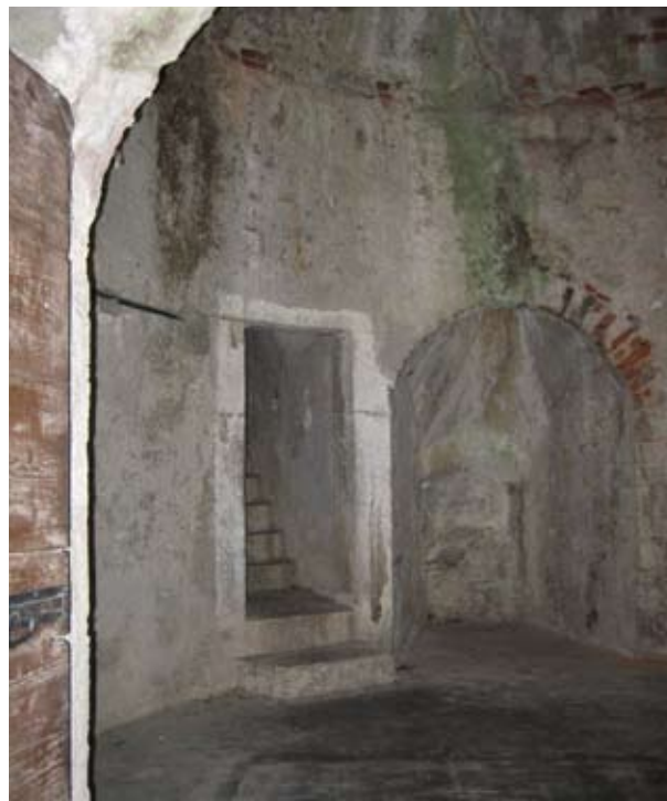
Scorcio della sala inferiore del torrione di Castagneta con particolare della botola
