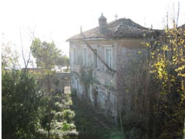
Casa del custode avviluppata dalla vegetazione
