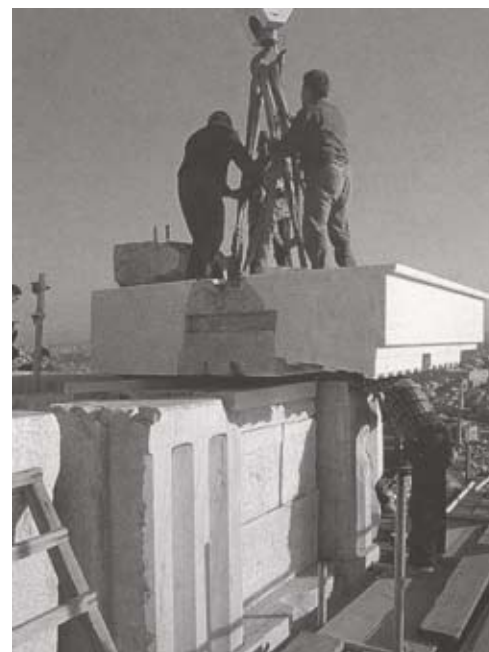
pagina precedente pavimentazione della cella del Partenone prima del restauro sopra a sinistra operazione di smantellamento. rimozione della cornice est sopra a destra ricollocazione della cornice sud est dopo il restauro
