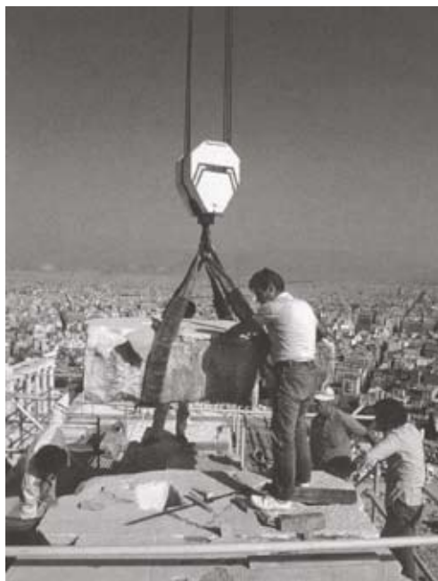
pagina precedente pavimentazione della cella del Partenone prima del restauro sopra a sinistra operazione di smantellamento. rimozione della cornice est sopra a destra ricollocazione della cornice sud est dopo il restauro
