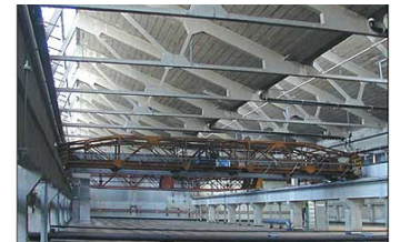
6. il sistema di copertura a travi reticolari nell'ex fabbrica di via Tortona 35
