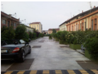
72-73. corti interne dopo l'intervento di riqualificazione sull'ex Richard Ginori
