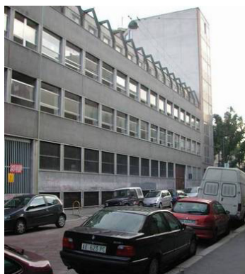
113-115. l'immobile prima dell'intervento di riqualificazione
