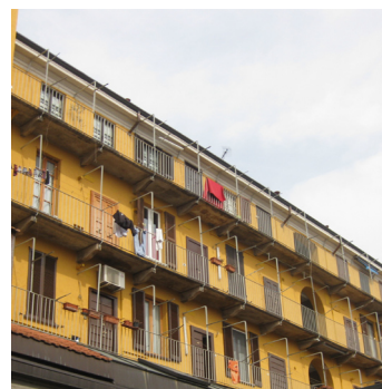
20. edifici a ballatoio in via Forcella
