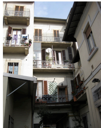
25. via Savona, corte interna
