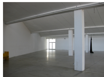
175. interni dopo l'intervento di riqualificazione
