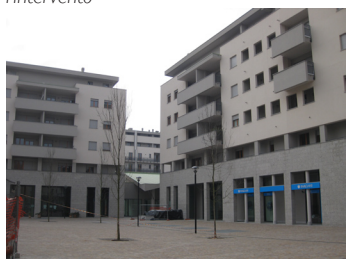
148. edifici residenziali che formano uno spazio cortilizio con servizi ai piani terra
