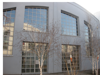
161. prospetto su corte interna
