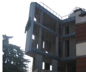
l 68. lavori in corso sul prospetto su via Ventura
