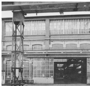
28. ingresso scarico carico merci dell'Ansaldo da Comune di Milano, 1982
