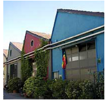
9. atelier e residenze nelle ex officine di via Savona 97
