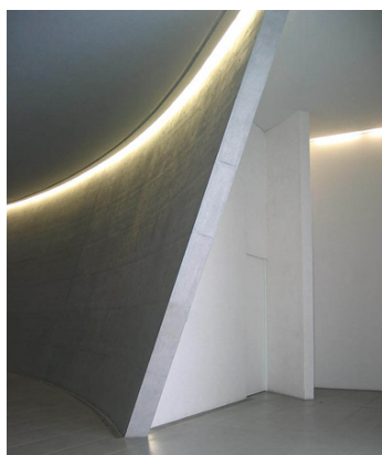
110. muro in calcestruzzo che delimita la promenade
