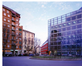
116. prospetto attuale all'incrocio tra via Tortona e via Bergognone
