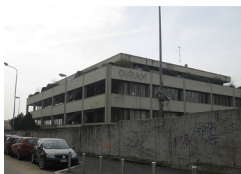
147. edificio ex Osram conservato dopo l'intervento
