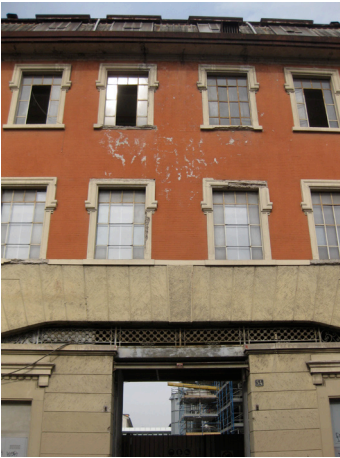
I 28. ingresso carico e scarico merci su via Tortona
