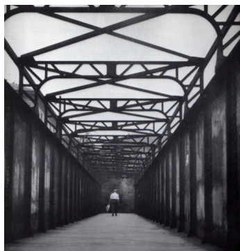
26. ponte pedonale in ferro sui binari della stazione di Porta Genova, da da Comune di Milano, 1982
