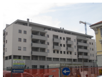
l.49. prospetto su via Savona
