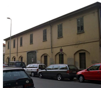
133. progetto su via Savona prima della riqualificazione
