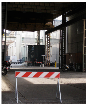
3. accesso scarico e carico delle merci dell'ex Riva Calzoni
