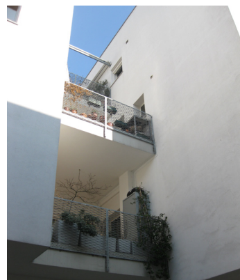
172. particolare delle logge interne
