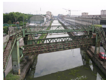
Il ponte metallico con meccanismo levatoio costruito per permettere all'industria Richard Ginori, localizzata lungo il Naviglio, di usufruire della ferrovia
