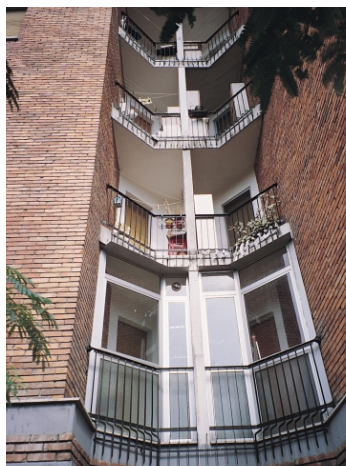
67. Particolare delle logge del corpo di fabbrica posto a chiusura dell'edificio I2, progettato da Giancarlo De Carlo
