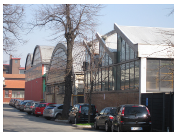
68-69. capannoni industriali a Lambrate
