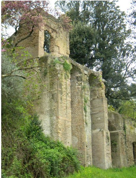
32_Torre di Tempe
