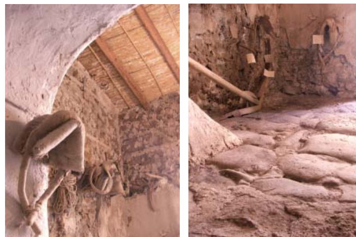
Figura 5.81. Incannucciato e pavimentazione.
