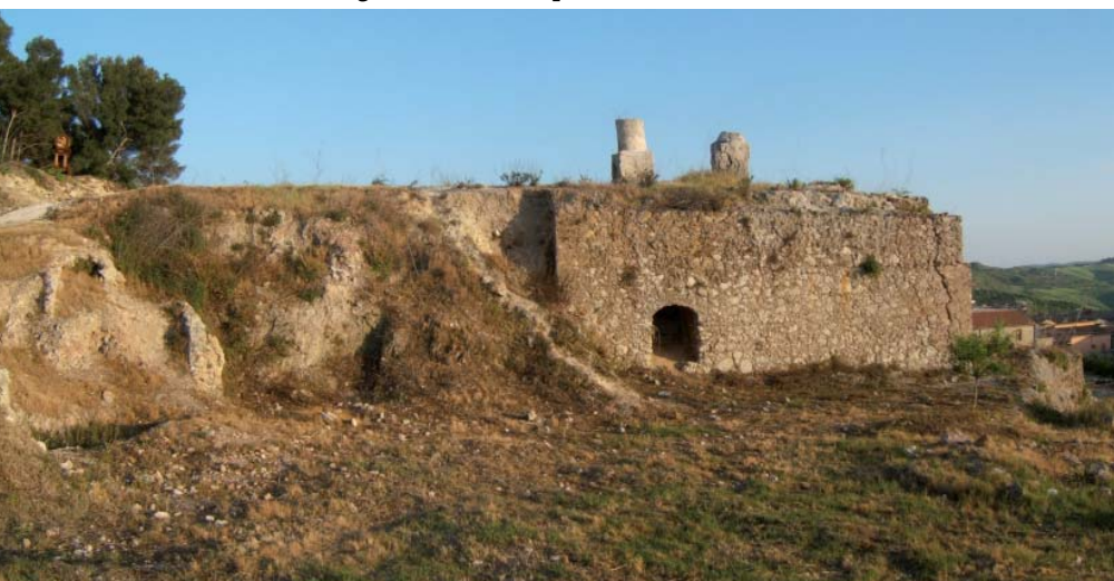
Figura 4.22. Fronte nord del forno Gill.
