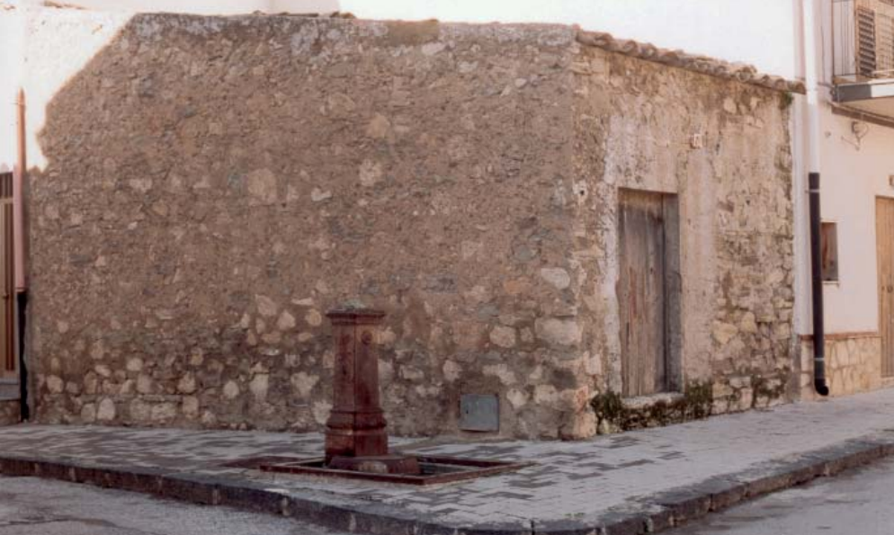
Figura 5.76. Dammuso realizzato con blocchi di gesso.
