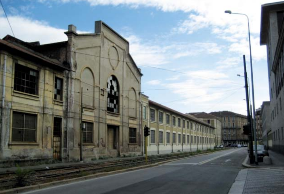
Figura 2.1. Stabilimento ex Carminati Toselli di Milano
