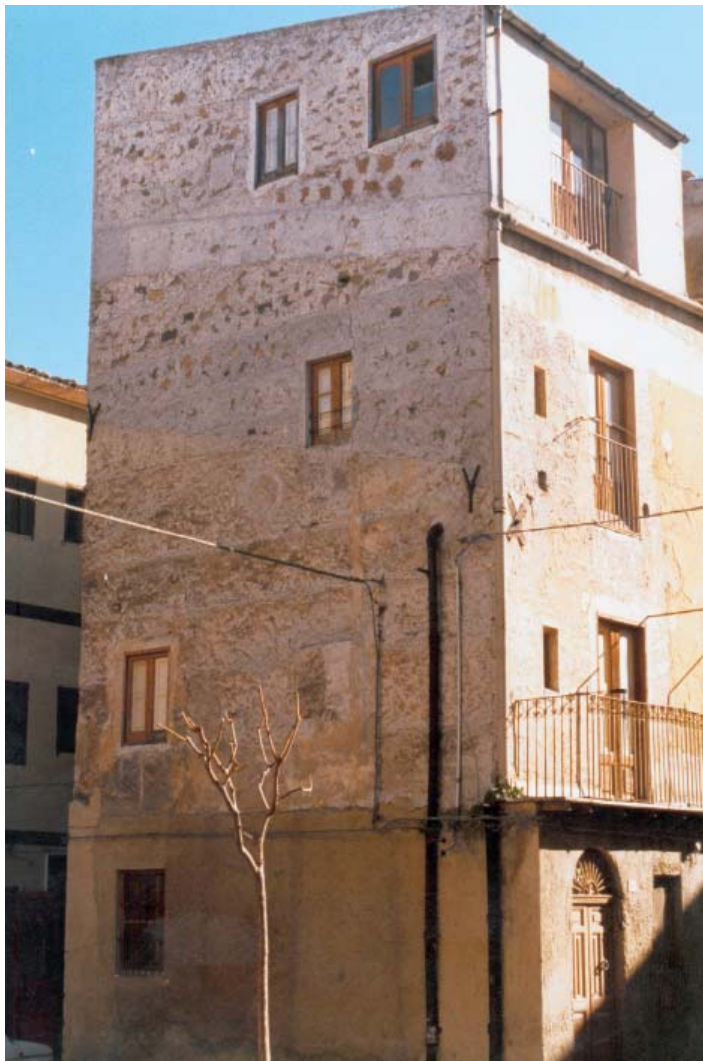
Figura 5.84. Abitazione a cui sono stati aggiunti piani.
