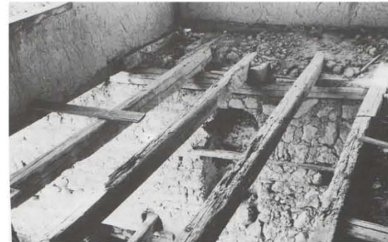
Disegno 47: il pavimento fatto con legni ,la casa di “Asmazlar” a Kastamonu.
