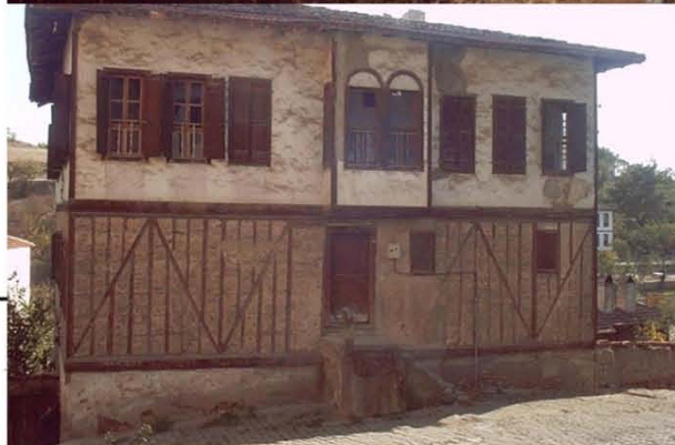
Disegno 100: lo scheletro con imbottitura di fango, la casa di "Akcasu" ,a Kastamonu.
