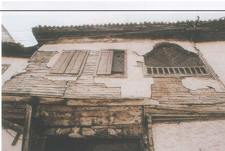
Disegno 103: lo scheletro di legno con stucco di "Bagdad", a Milas
