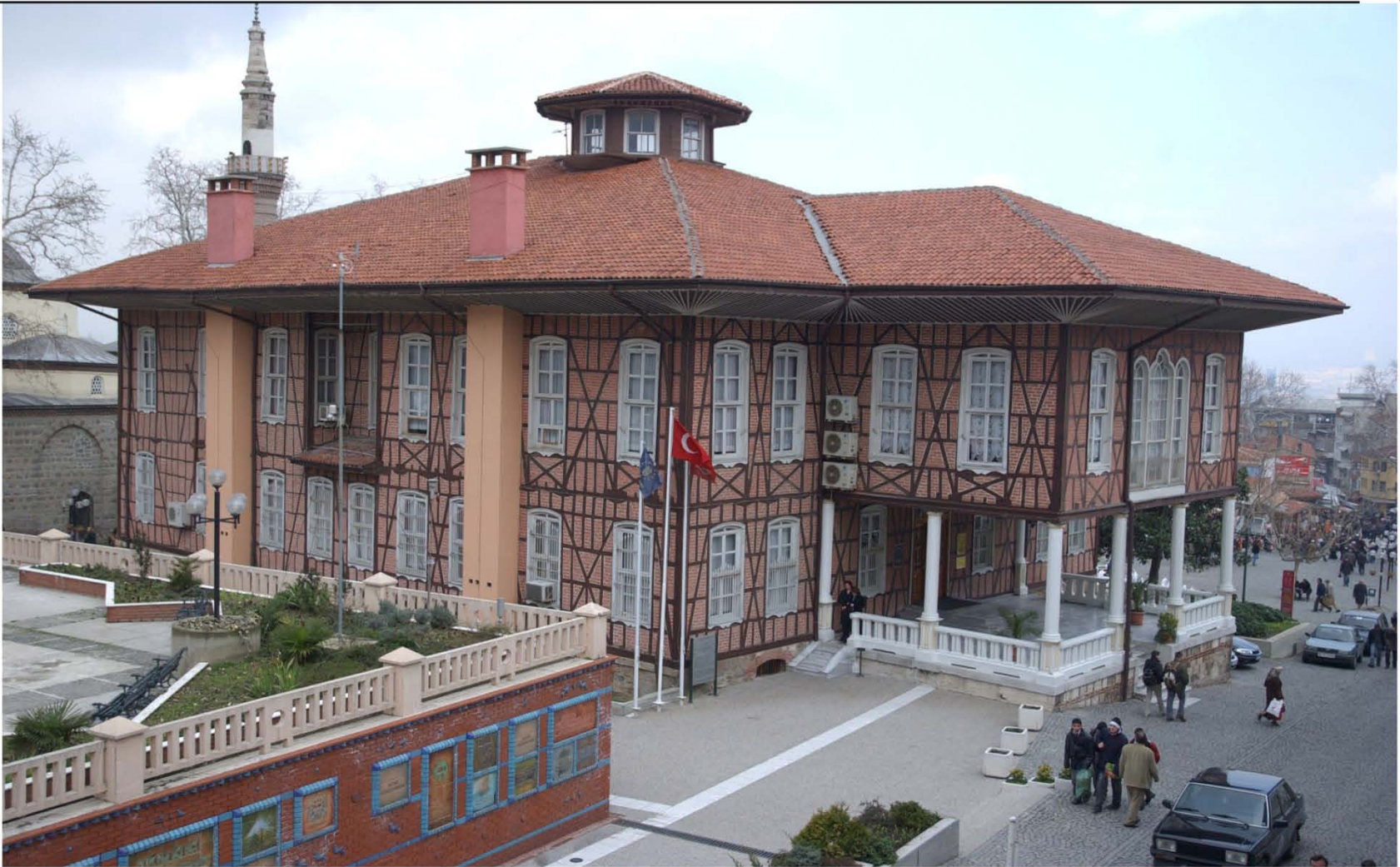
Disegno 101: lo scheletro con imbotterà di laterizi , la costruzione di municipio, a Bursa.
