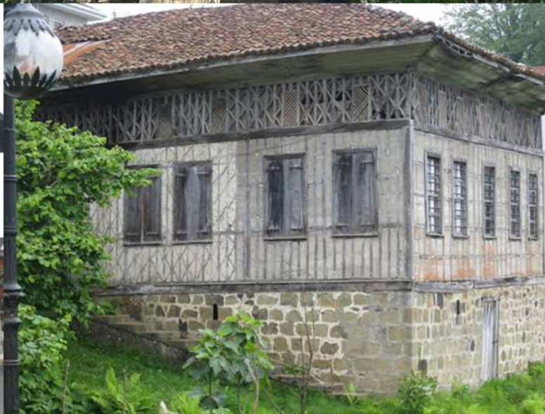
Disegno 102: lo scheletro con imbottitura di pietra , le case di "Trabzon" .
