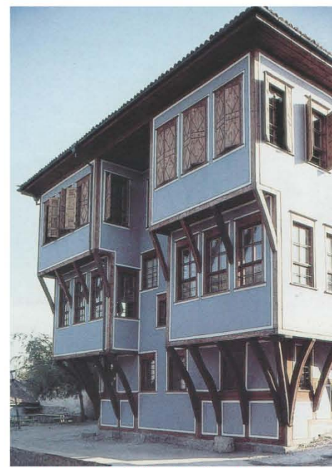
Disegno 66: le finestre di accordata con "cumba", la casa di "pierre loti", a Plovdiv, in Bulgaria.
