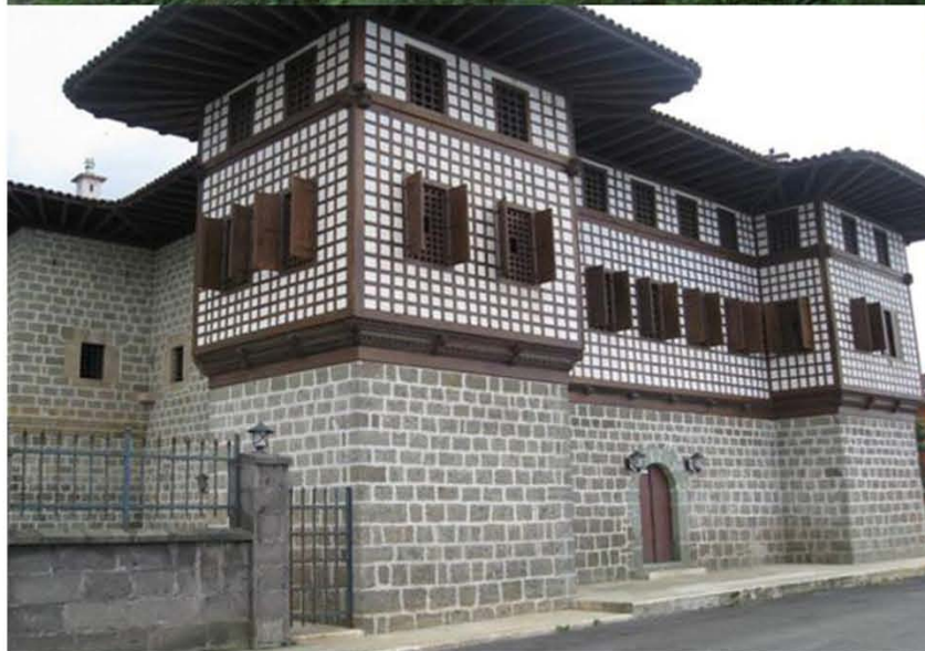
Disegno 102: lo scheletro con imbottitura di pietra , le case di "Trabzon" .
