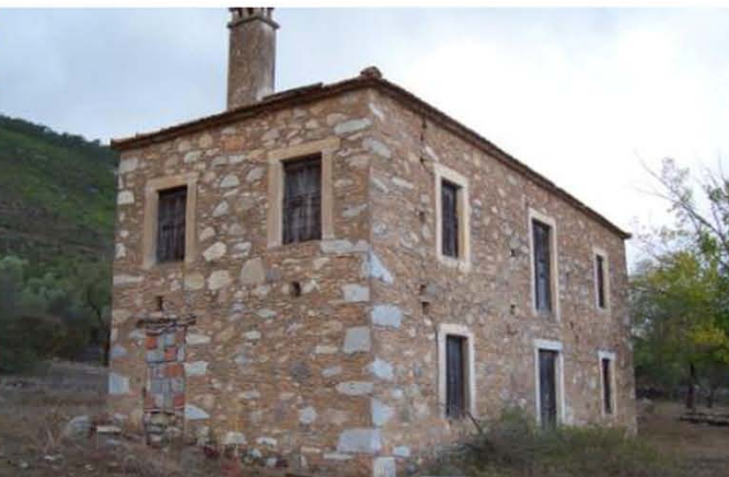
Disegno 54: un esempio del tetto pianeggiato ,a Bodrum.
