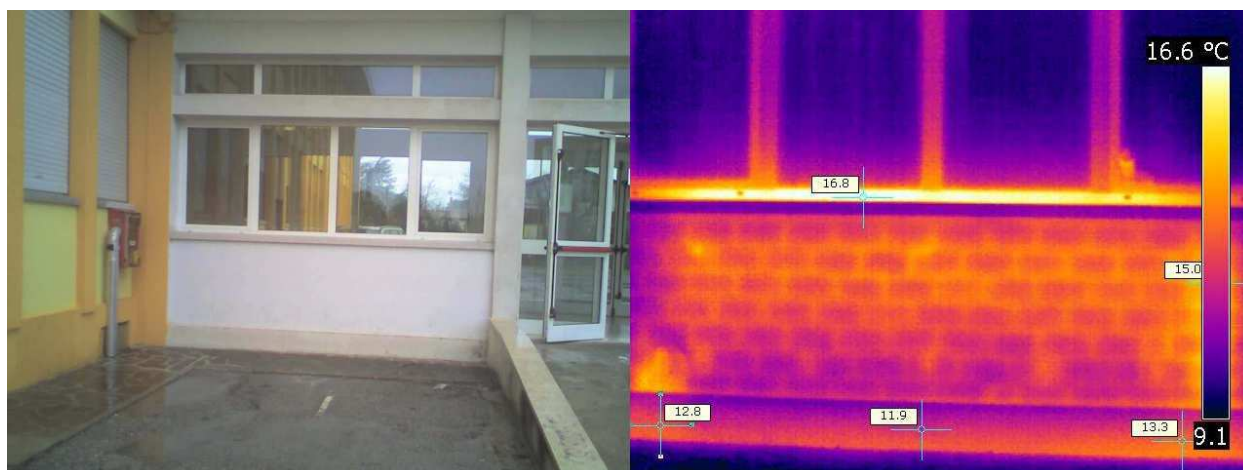
Figura 14 Tessitura del muro
