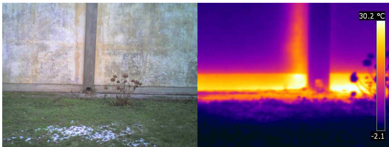
Figura 13 Presenza di impianti
