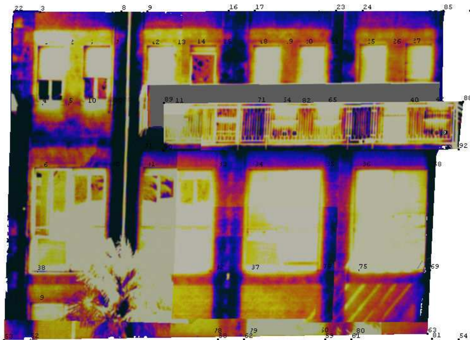
Figura 64 Ricostruzione facciata edificio nel termico
