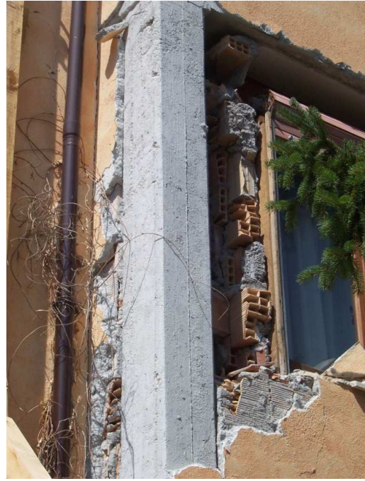
Figura 5.39. Esempi di danni gravi ad edifici in cemento armato a San Gregorio
