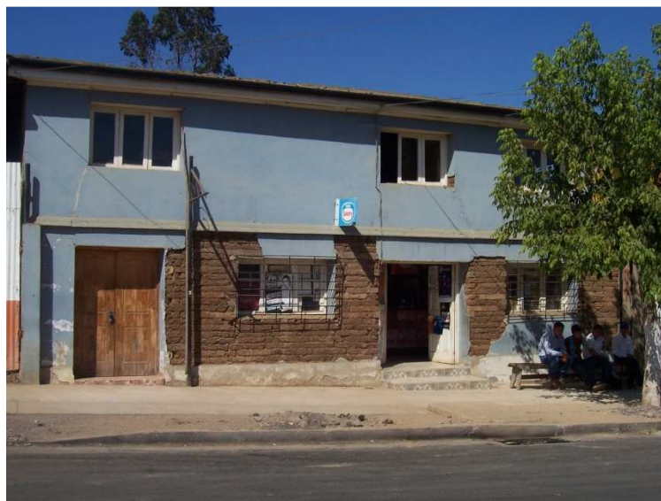
Figura 8.34. Paredones. Casa in adobe di due piani. Danno di grado 2
