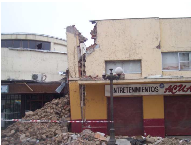
Figura 8.48, 8.49 e 8.50. Talca. Hotel Terranova (in alto a sinistra) Casa in muratura. Danno di grado 4 (in basso) Edificio di 18 piani. Danno di grado 1 (in alto a destra)
