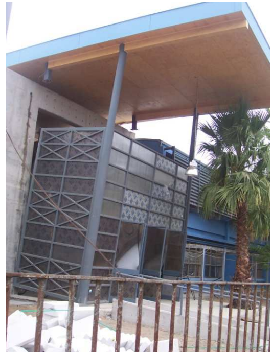
Figura 8.28, 8.29 e 8.30. Pichidegua. Scuola in cemento armato (in alto) Ingresso della scuola; si è sganciato dal muro e si è spostato di circa 50 cm (in basso a destra) Casa di mattoni (in basso a sinistra)
