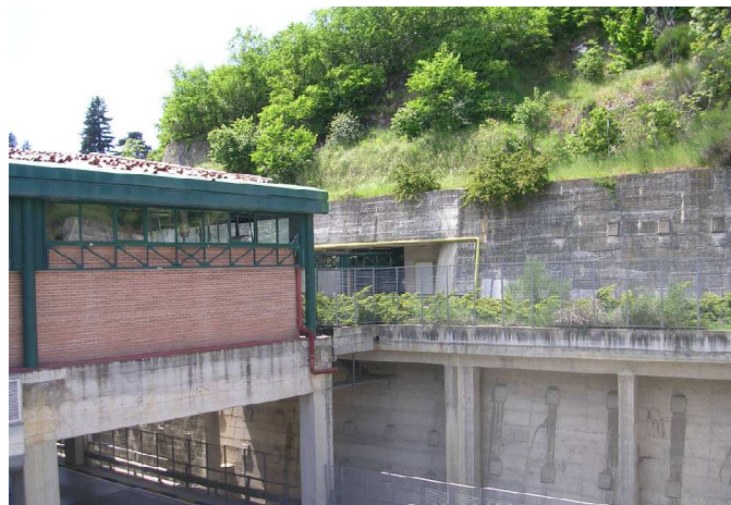
Figura 6.3. Postazione accelerometrica AQK (dietro la stazione dei bus)
