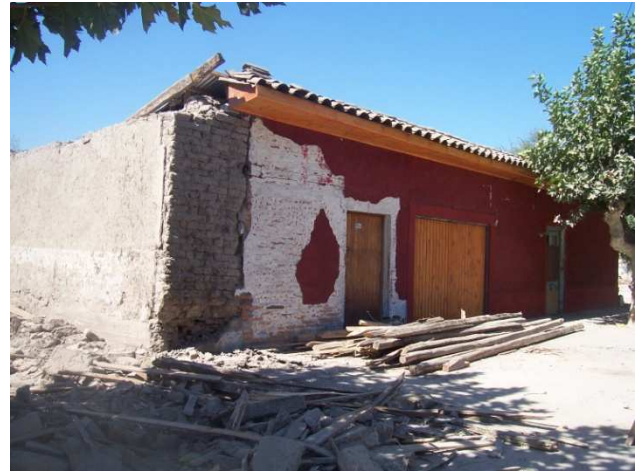
Figura 8.32 e 8.33. Comune di Peralillo, completamente collassato (a sinistra) Da destra: Casa in adobe (danno di grado maggiore o uguale a 3), Casa in muratura (danno di grado 2), Casa in adobe (danno di grado 5) (a destra)
