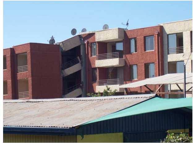
Figura 8.63 e 8.64. Edificio Don Luis gravemente danneggiato. Danno grado 5 (a sinistra) Edificio Don Tristan gravemente danneggiato. Danno grado 5 (a destra)
