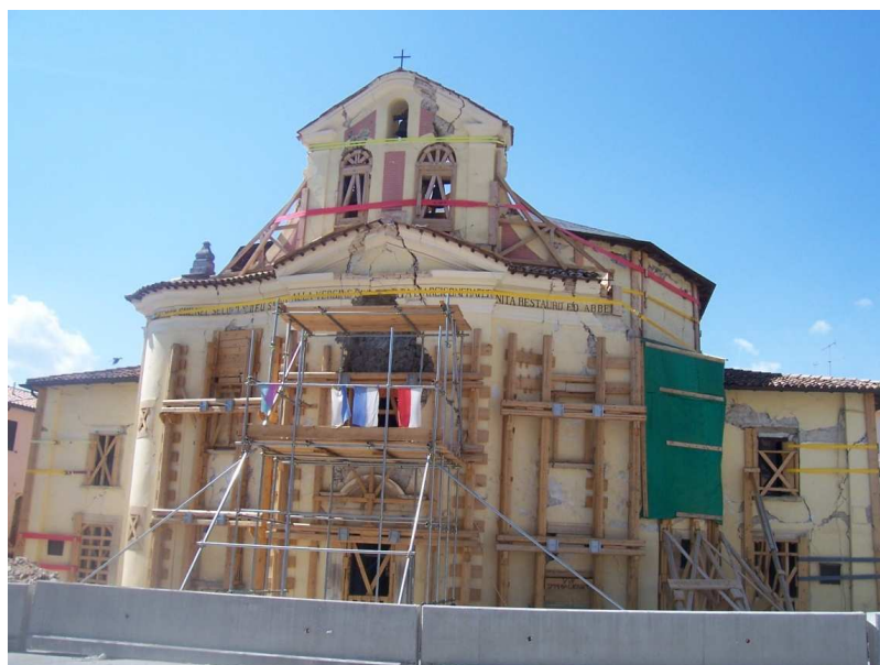
Figura 5.43. Chiesa a Paganica in fase di ristrutturazione (foto di inizio settembre 2009)
