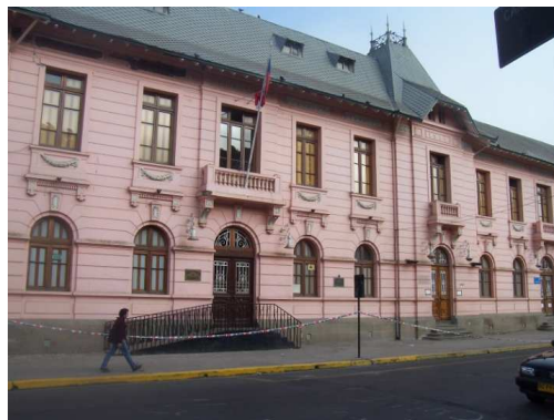
Figura 8.41. Edificio del 1915. Danno di grado 2
