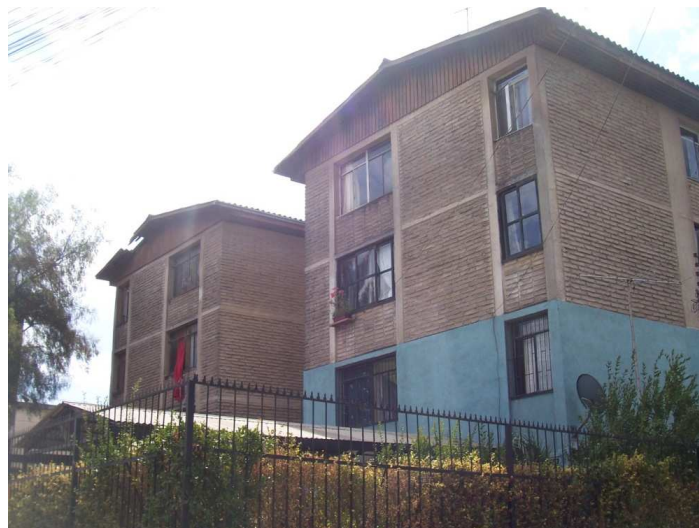
Figura 8.57. Tipica casa comunale in muratura confinata. Non presenta alcun danno
