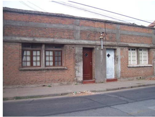
Figura 8.39 e 8.40. San Fernando. Casa in adobe. Danno di grado 4 (a sinistra) Casa in muratura confinata. Danno di grado 1 (a destra)
