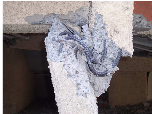
Figura 8.65 e 8.66. Danni ai pilastri dell'edificio Don Luis a Maipù
