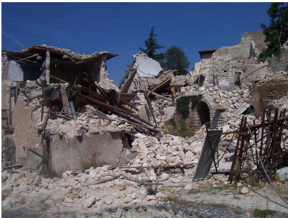
Figura 5.27. Collasso di alcune abitazioni della parte alta del paese di Castelnuovo. In questa zona le strutture sono principalmente in muratura in pietra grezza (a sacco di ciottoli, pietrame, mista) (foto di inizio settembre 2009)
