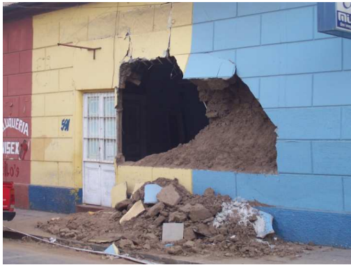
Figura 8.39 e 8.40. San Fernando. Casa in adobe. Danno di grado 4 (a sinistra) Casa in muratura confinata. Danno di grado 1 (a destra)
