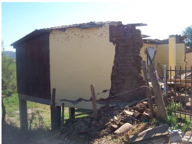
Figura 8.44 e 8.45. Licantén. Casa in muratura costruita su di un terreno di riporto. Danno di grado 5 (a sinistra) Casa in muratura. Danno di grado 1 (a destra)
