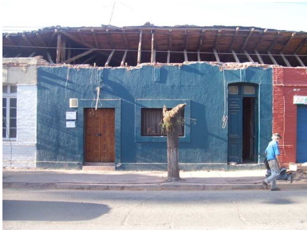
Figura 8.35 e 8.36. Santa Cruz. Casa in mattoni, caduta del solaio. Danno di grado 2 Casa in adobe, tetto rifatto in seguito al terremoto del 1985. Danno di grado 1
