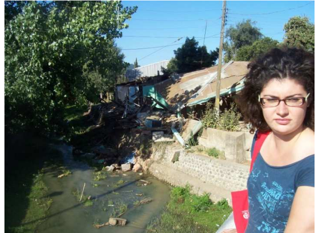
Figura 8.46 e 8.47. Curepto. Casa di muratura confinata. Danno di grado 1 (a sinistra) Case in adobe costruite al lato del fiume. Danno di grado 5 (a destra)
