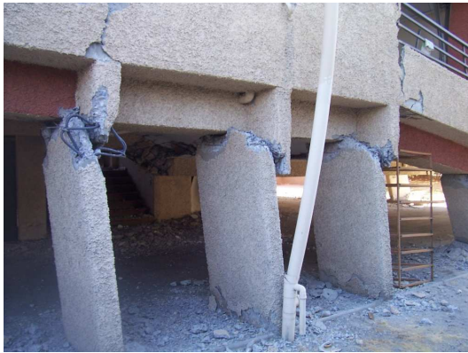
Figura 8.65 e 8.66. Danni ai pilastri dell'edificio Don Luis a Maipù
