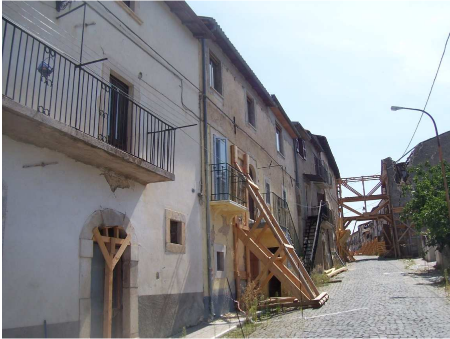
Figura 5.28. Alcune abitazioni della zona bassa di Castelnuovo. In questa parte del paese si trovano sia costruzioni in pietra grezza che in pietre squadrate (foto di inizio settembre 2009)
