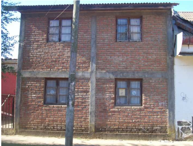
Figura 8.46 e 8.47. Curepto. Casa di muratura confinata. Danno di grado 1 (a sinistra) Case in adobe costruite al lato del fiume. Danno di grado 5 (a destra)
