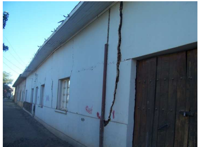
Figura 8.26 e 8.27. Peumo. Particolare di una casa in adobe con danno di grado 3 (a sinistra) Casa in adobe. Danno di grado 3 (a destra)
