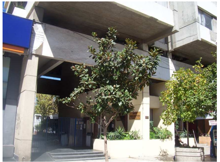
Figura 8.20 e 8.21. Rancagua. Edificio di 14 piani degli anni '60. Danno di grado 1 (a sinistra) Particolare dell'edificio di 14 piani: il piano terra debole (a destra)
