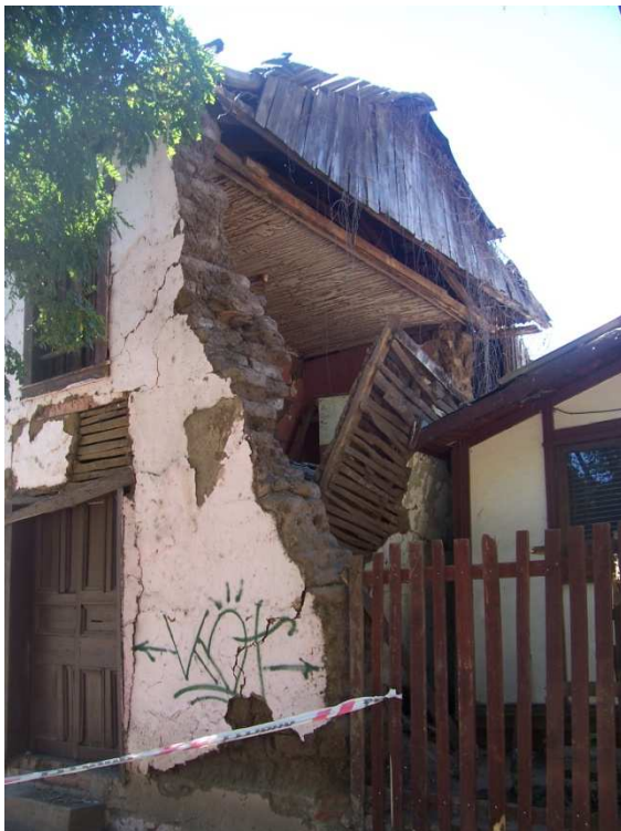
Figura 8.22 e 8.23. Machali. Casa in adobe. Danno di grado 5 (a sinistra) Casa in adobe. Danno di grado 3 (a destra)
