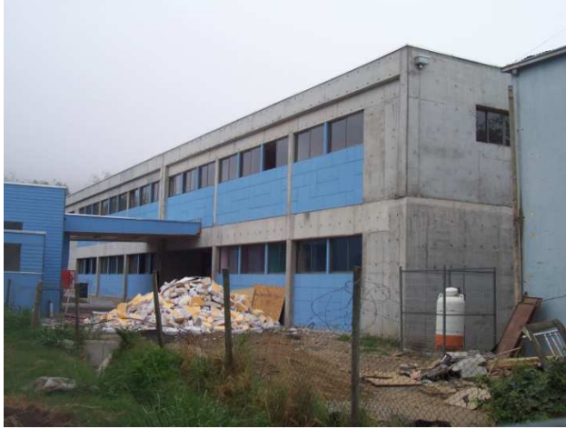
Figura 8.28, 8.29 e 8.30. Pichidegua. Scuola in cemento armato (in alto) Ingresso della scuola; si è sganciato dal muro e si è spostato di circa 50 cm (in basso a destra) Casa di mattoni (in basso a sinistra)
