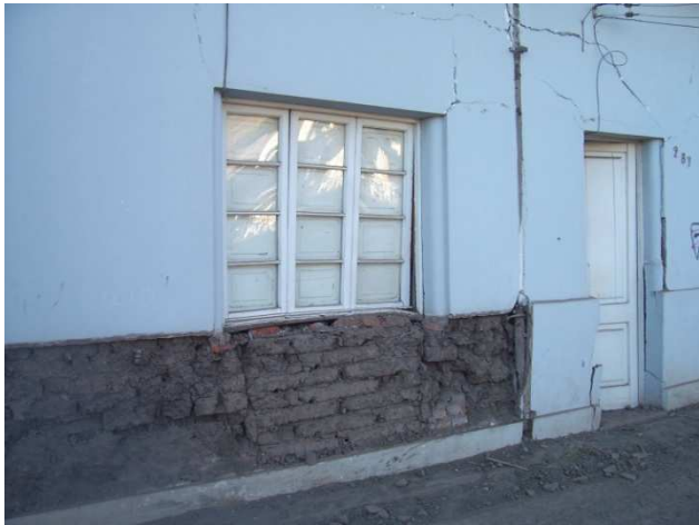
Figura 8.26 e 8.27. Peumo. Particolare di una casa in adobe con danno di grado 3 (a sinistra) Casa in adobe. Danno di grado 3 (a destra)
