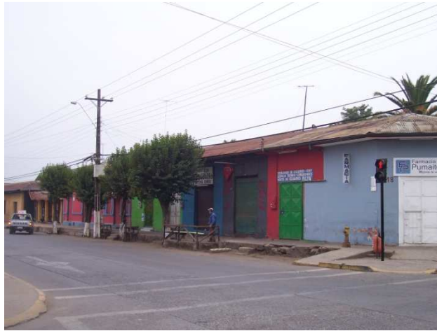
Figura 8.43. Romeral. Case in adobe con tetto in metallo. Danno di grado 2
