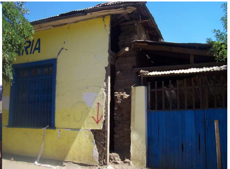
Figura 8.22 e 8.23. Machali. Casa in adobe. Danno di grado 5 (a sinistra) Casa in adobe. Danno di grado 3 (a destra)
