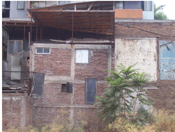
Figura 8.18. Esempio di una casa in muratura povera, essendo confinata ha retto ottimamente senza presentare alcun danno. Foto scattata a Santiago il giorno stesso della scossa principale
