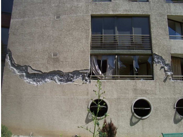
Figura 8.60 e 8.61. Particolari di un edificio di 20 piani con pareti di taglio Livello scantinato dell'edificio
