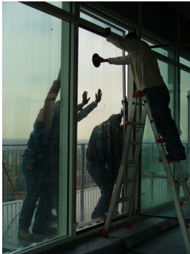
Fig. 6.3 Rimozione lastra di vetro facciata esterna
