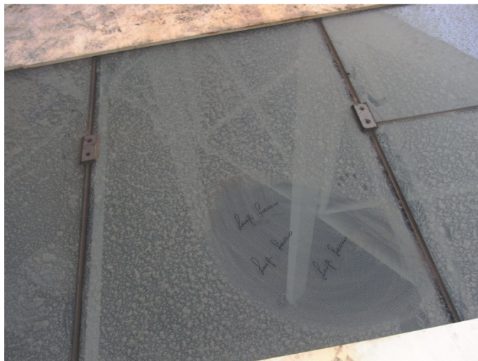
Fig. 6.5 Prelievo del provino lastra stratificata di copertura
