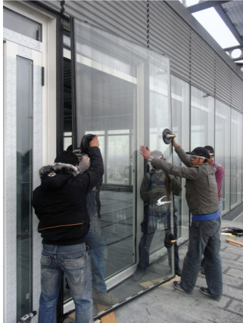
Fig. 6.4 Prelievo del provino - specchiatura esterna di facciata
