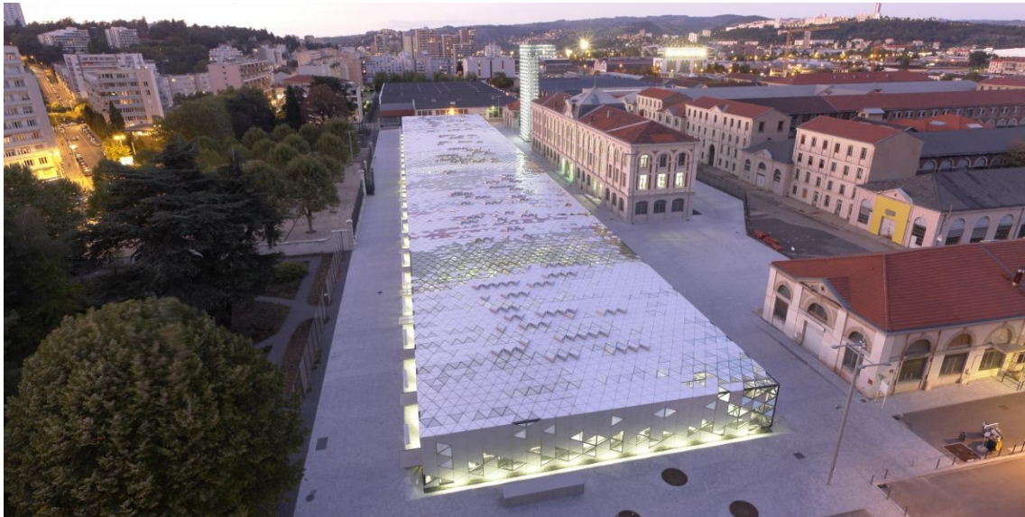
Oggetto: Cité du Design Luogo/Anno Saint Étienne (Francia), 2006 Progettista: LIN Riferimento architettonico: esempio di studio scocca di rivestimento/copertura e sua modularità
