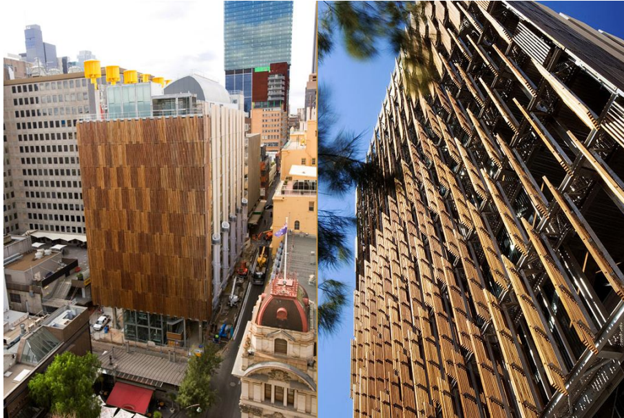
Oggetto: CH2 – Council House of Melbourne Luogo/Anno Melbourne (Australia), 2006 Progettista: Città di Melbourne e gruppo DesignInc Riferimento architettonico: esempio di analisi delle soluzioni tecniche/ecosostenibili adottabili
