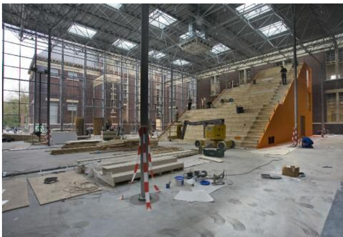
Figura 45 costruzione dello spazio esibizioni
