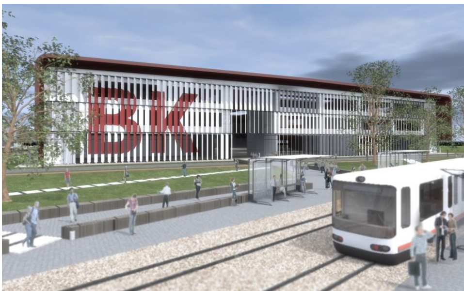
Figura121 fronte ovest ; pannelli mobili in facciata
