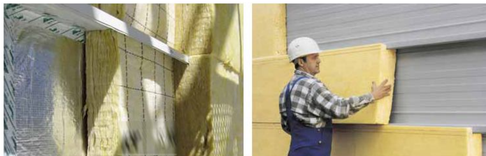
Figura 199 posa dell'isolante in fibra di vetro riciclato
