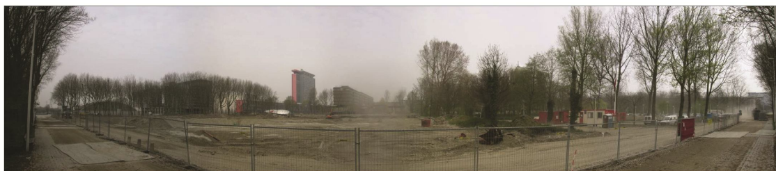
Figura 6.287 vista dell'area di progetto ad altezza uomo
