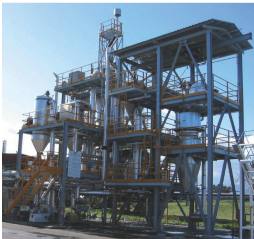
Figura 24. Impianto pilota di gassificazione delle biomasse a letto fluido ricircolante del centro ENEA della Trisaia
