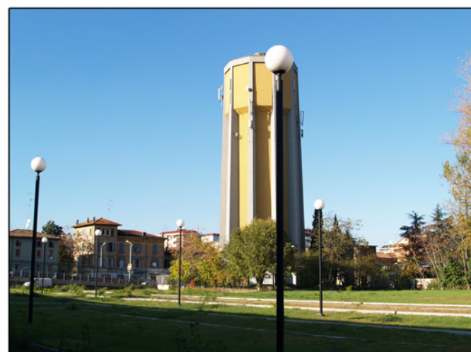
14. Serbatoio idrico a torre
