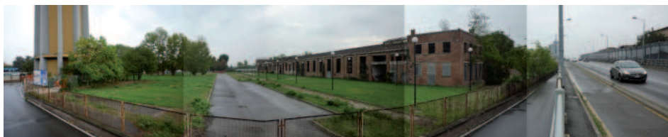
Figura 6.1 Vista della facciata nord dal viale Ciro Menotti
