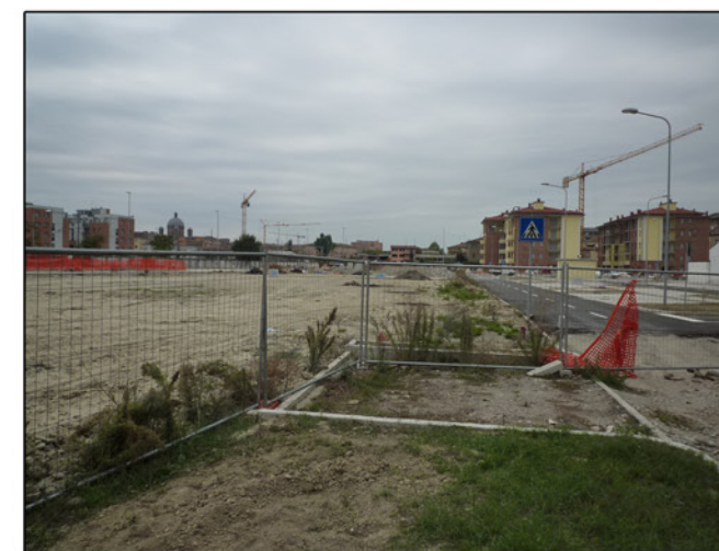
11. Costruzione di edifici residenziali
