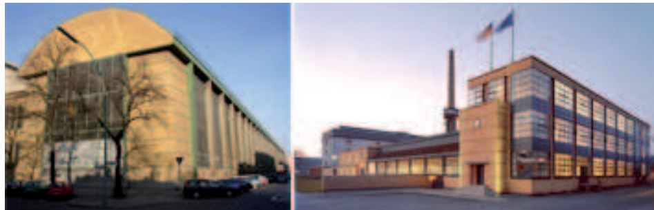
Figura 2.12 La Turbinenfabrik La fabbrica Fagus
