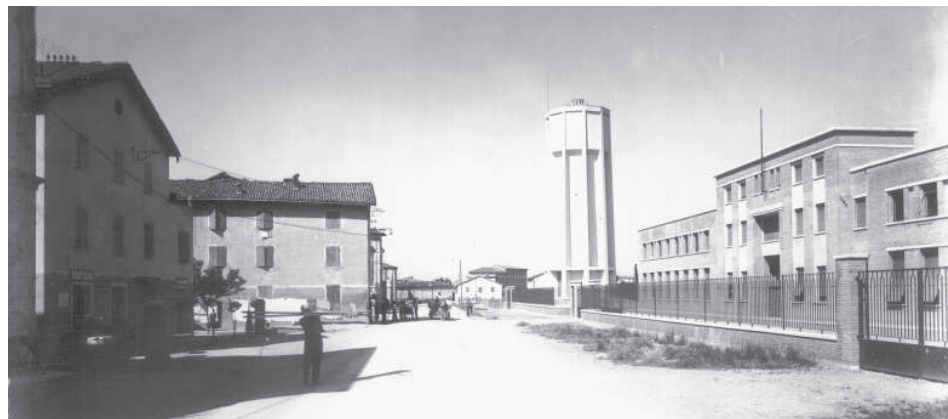
Figura 6.4 Vista della fabbrica e del serbatoio nel 1940 subito dopo la costruzione
