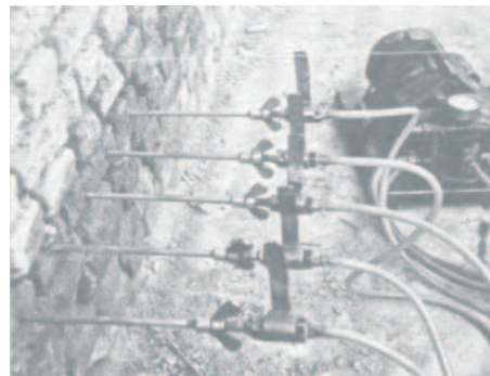
Iniezioni a pressione di formulati chimici idrofobizzanti
