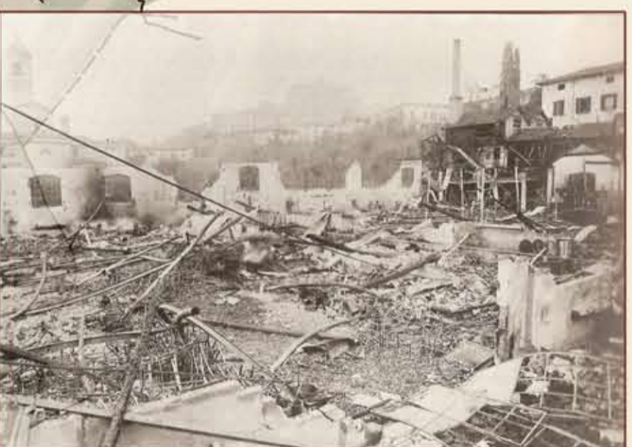
INCENDIO DELLA BELTRAMI, 1936
