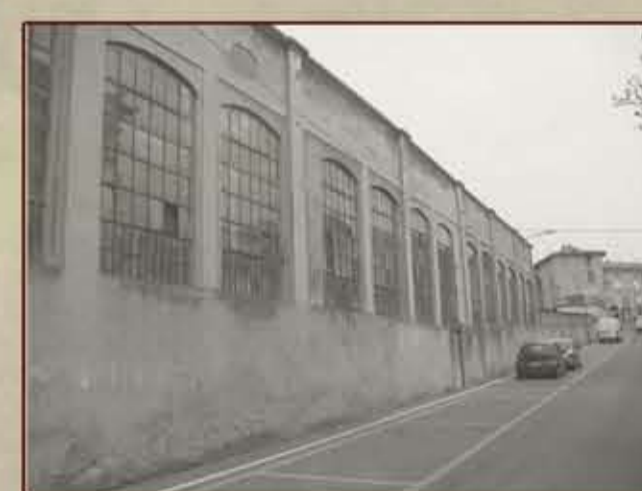
MURO DI CONFINE SU VIA BALLADORE
