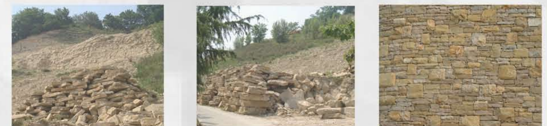
RIVESTIMENTO ESTERNO: PIETRA DI CREDARO POSATA A SEMISECCO
