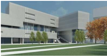
Figura 31. Veduta dell'edificio in linea per uffici.
