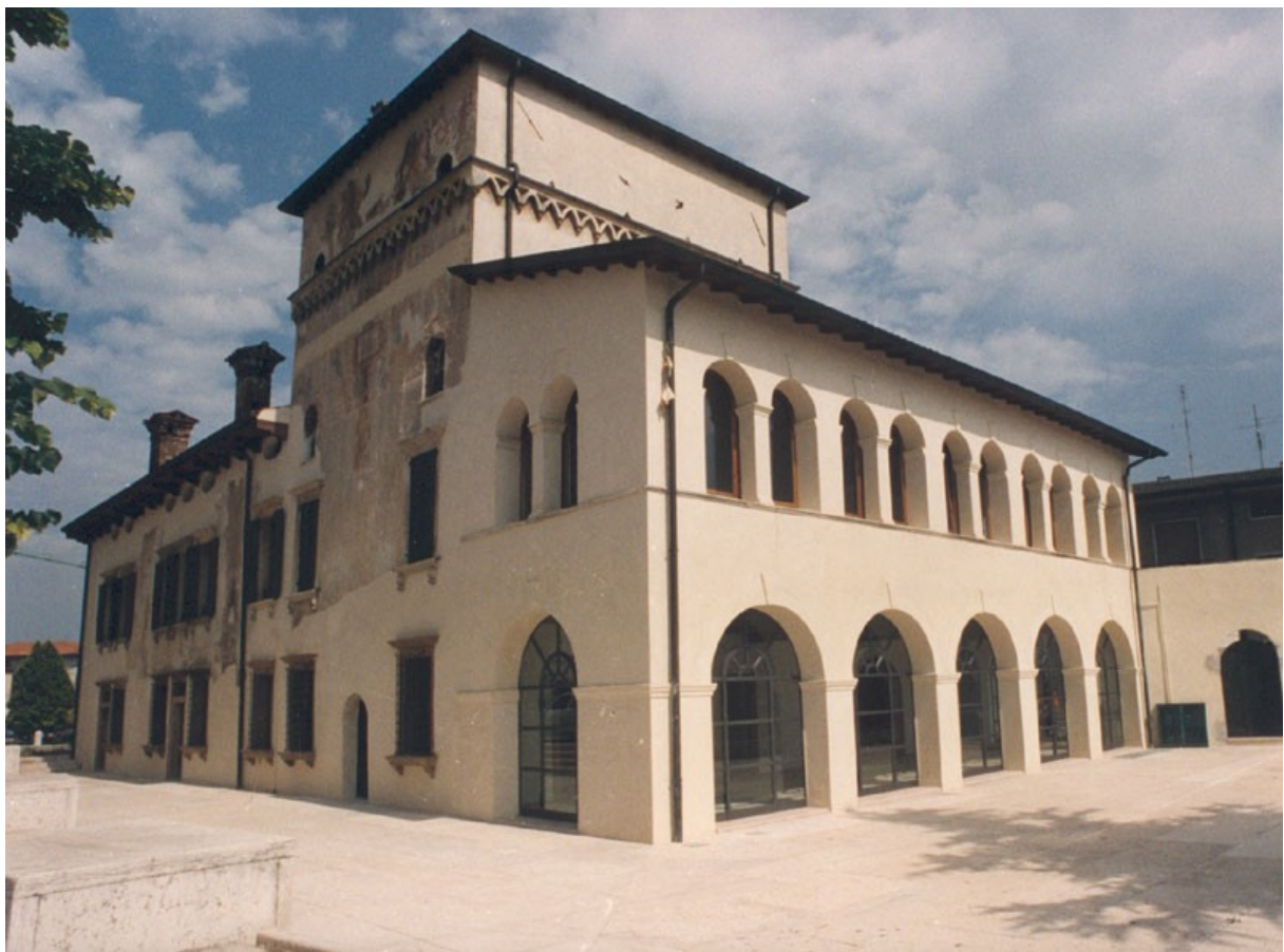
Fig. 83-84. Palazzetto Balladoro prima e dopo l'intervento di ristrutturazione
