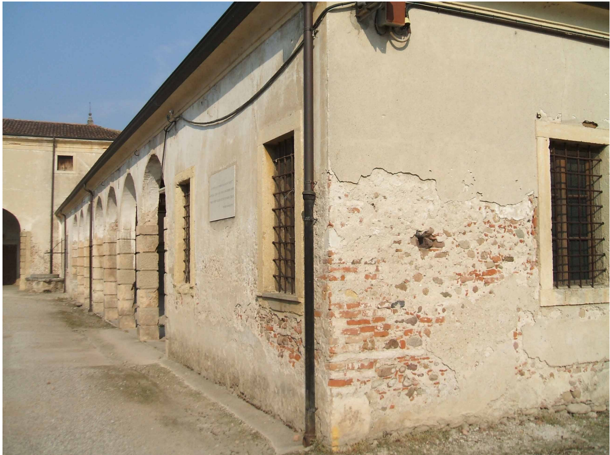
Fig. 24. Fabbricato rustico di destra. Muratura mista in laterizi e ciottoli morenici, pilastri degli archi e cornici delle aperture in pietra tenera
