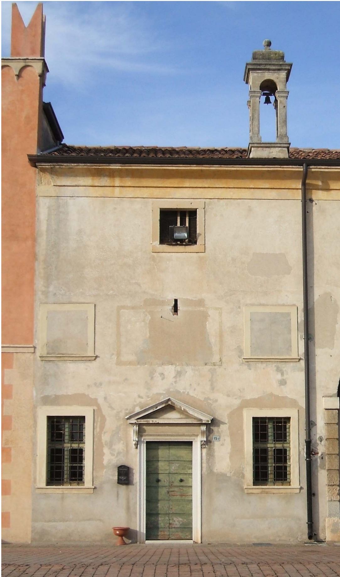
Fig. 21. Cappella gentilizia. Prospetto esterno
