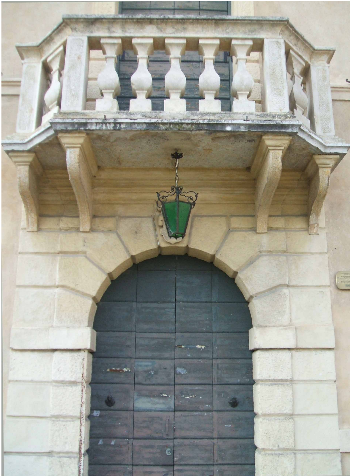
Fig. 22. Particolare dell'ingresso principale, con l'arco bugnato sovrastato dal piccolo balcone balastrato
