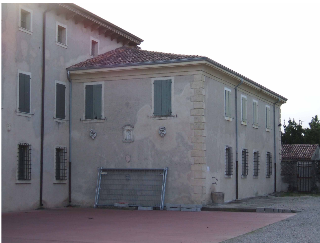
Fig. 37. Corpo architettonico sporgente dal fronte posteriore della Villa
