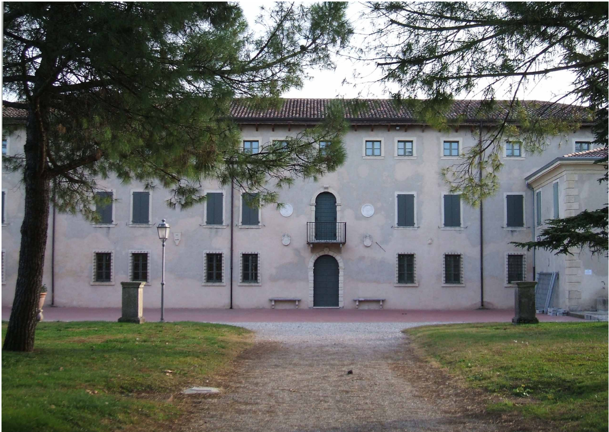
Fig. 33. Edificio dominicale. Facciata retrostante prospiciente sul parco
