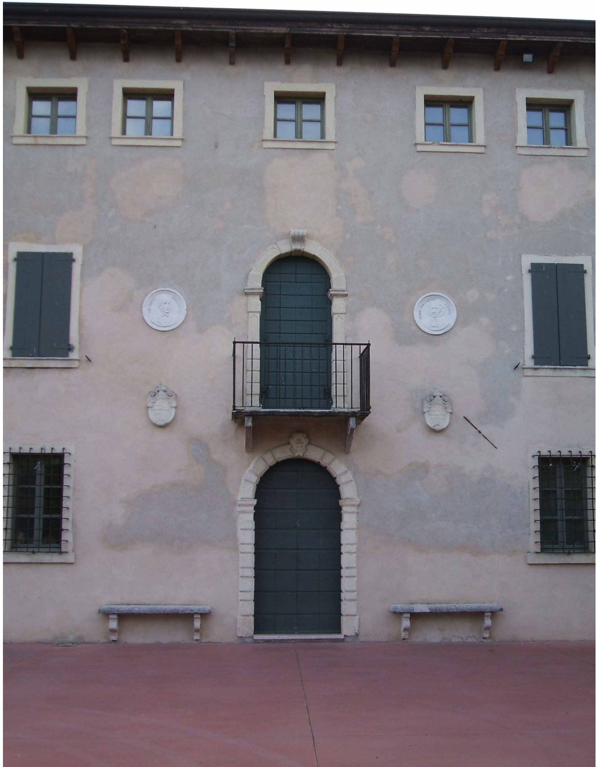
Fig. 36. Facciata retrostante dell'edificio dominicale. Particolare
