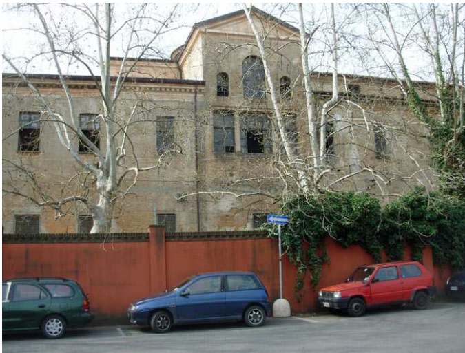
8.3. La parte del convento in disuso sul lato interno.
