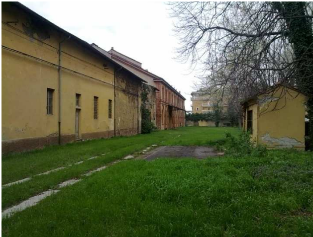
16. L'interno dismesso del complesso.
