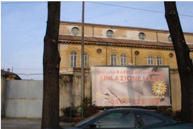
24.1, 24.2 Lato principale e fianco dell'edificio.
