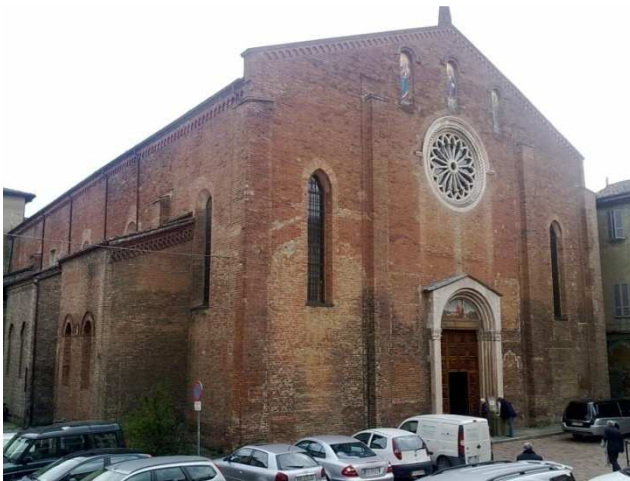
15.1. La facciata dell'edificio religioso.
