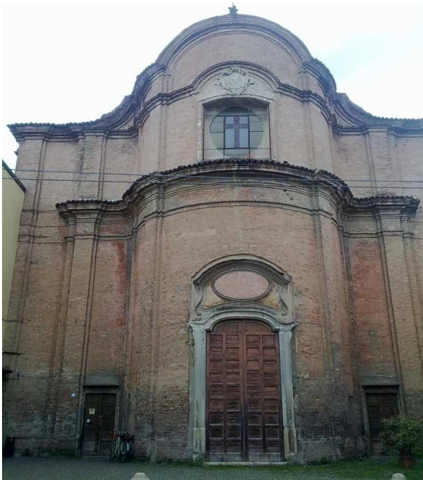
13.1. La facciata dell'edificio religioso.
