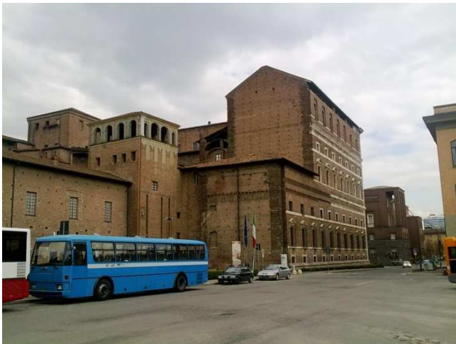
14.1. Il corpo di fabbrica di Palazzo Farnese costruito sul precedente impianto della cittadella.
