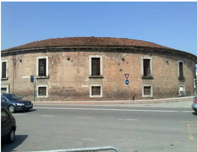
23.1. L'esterno dell'edificio nella vista dal lato interno della città.
