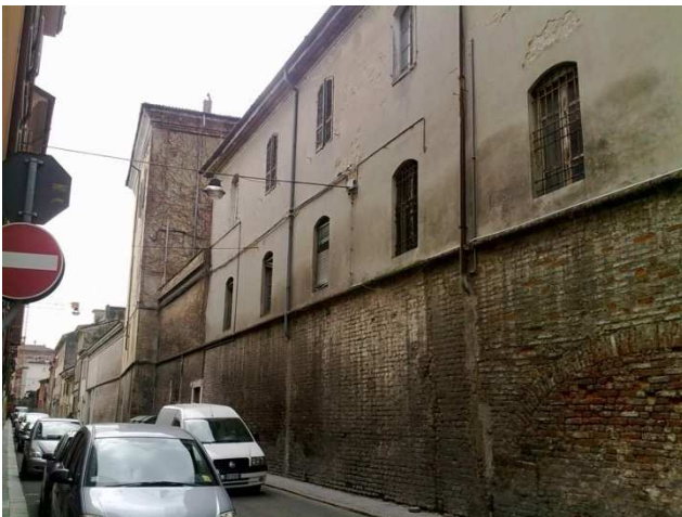
22.1, 22.2 Il fianco del gigantesco edificio dismesso adibito a parcheggio e il fronte su via dell'Abbondanza.
