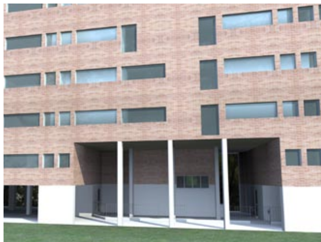
1. Stato attuale portineria
