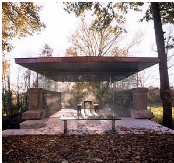
15. Fronte meridionale Glass Pavilion, Burgundy, Francia, 2001
