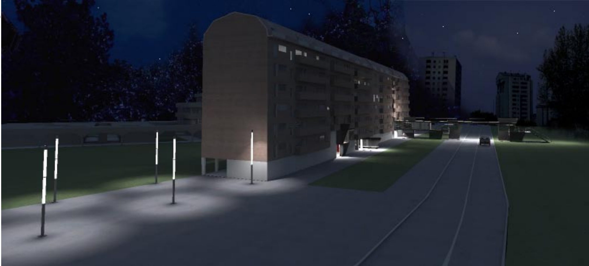
42. Vista del fronte esterno
