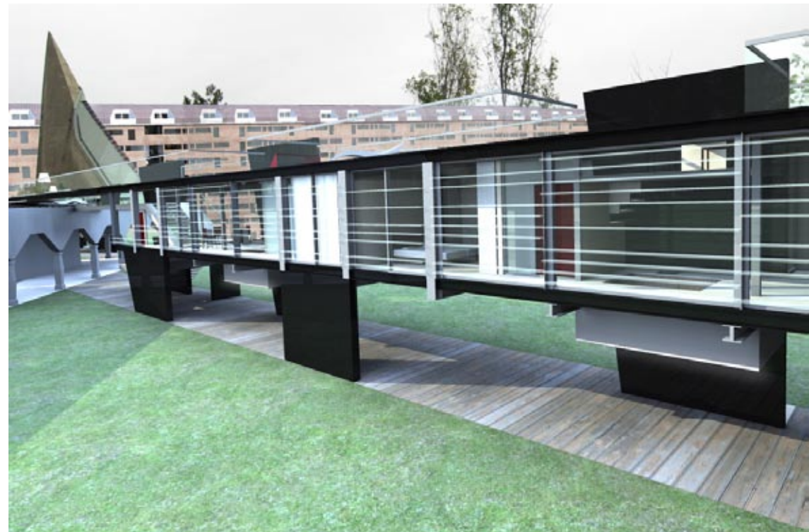
34. Vista della nuova terrazza della biblioteca
