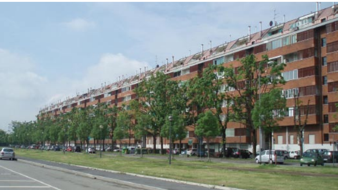
14. Fronte esterno del quartiere
