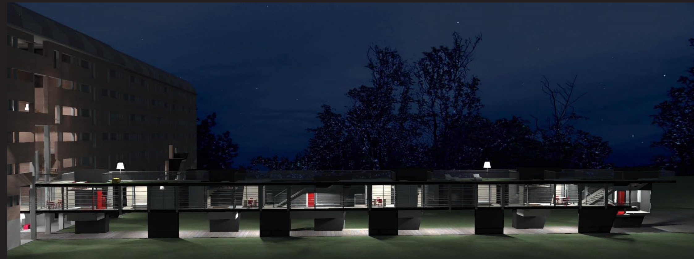
32. Vista notturna dei nuovi alloggi
