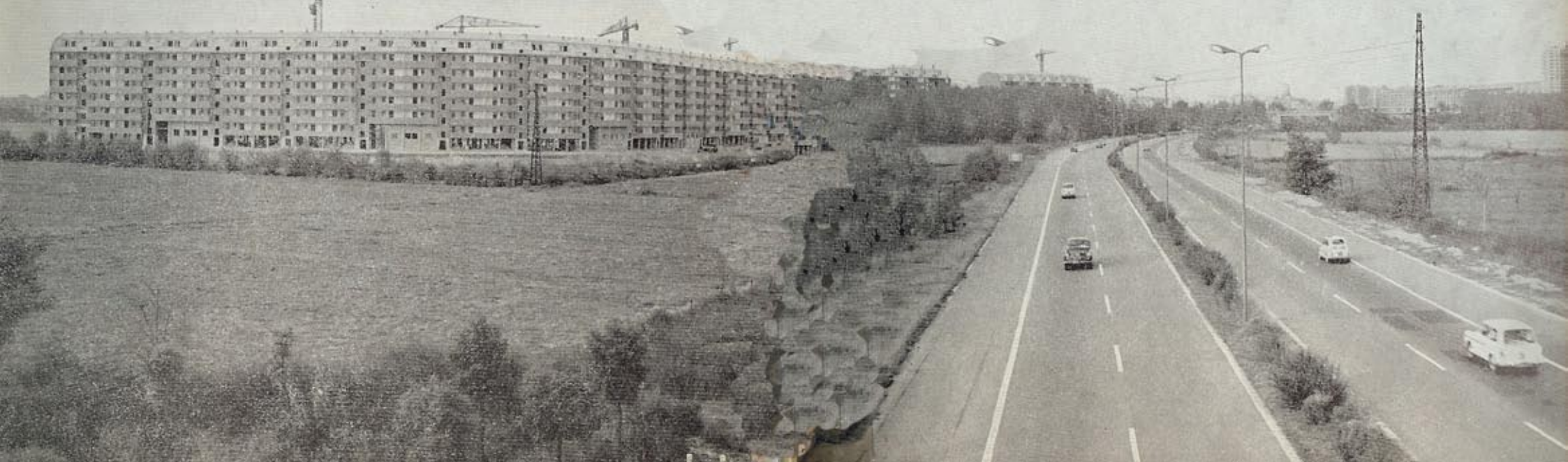
5. Vista dall'autostrada del quartiere Sant'Ambrogio I in costruzione
