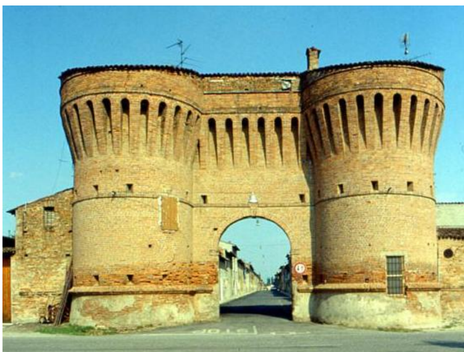
Figura 109 Il Torrione di Porta Brescia lungo il confine ovest della cinta muraria. Si distingue dagli altri due per l'assenza delle merlature e perché coperto mediante copertura a doppia falda. È l'unico ancora di proprietà provata.
