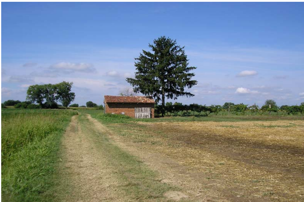
Figura 26 (4a_W_021): Uno dei numerosi "casotti" ancora presente nelle campagne. Un tempo numerosi offriva ricovero notturno al bestiame da tiro utilizzato per i lavori nei campi. Questi piccoli edifici hanno spesso identificato i luoghi del territorio.
