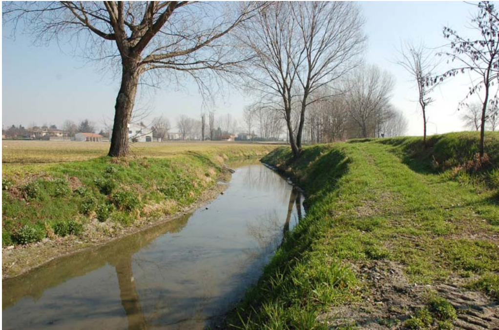
Figura 43 (6b_E_020): L'immagine documenta il canale "Riglio Delmonazza" in prossimità del ponte lungo la strada provinciale per Casalmaggiore, a valle dello stesso. In tale tratto il Canale conserva il suo tracciato storico con andamento moderatamente meandriforme.
