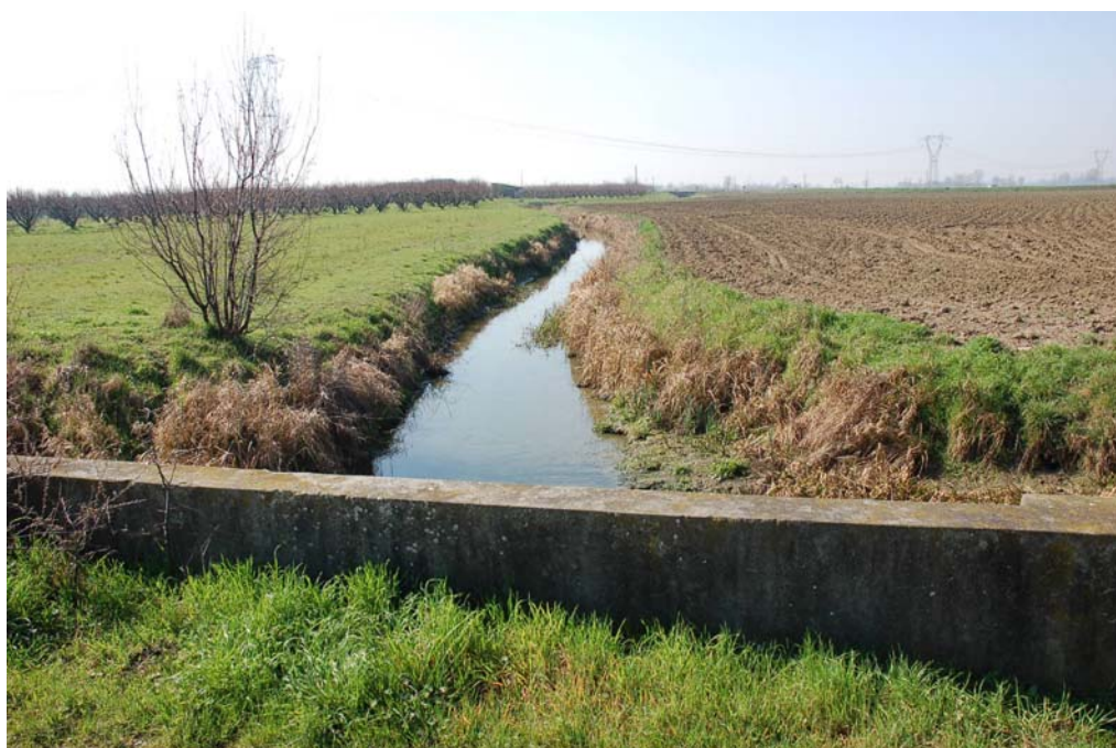
Figura 51 (7c_W_030): Il Colatore Padiola documentato dal ponticello lungo la strada vicinale Pradelle, nel settore est dell'unità cartografica. Sullo sfondo, a sinistra, si vede un'ampia superficie coltivata a frutteto, ed oltre l'elettrodotto da 380.000 Volt.
