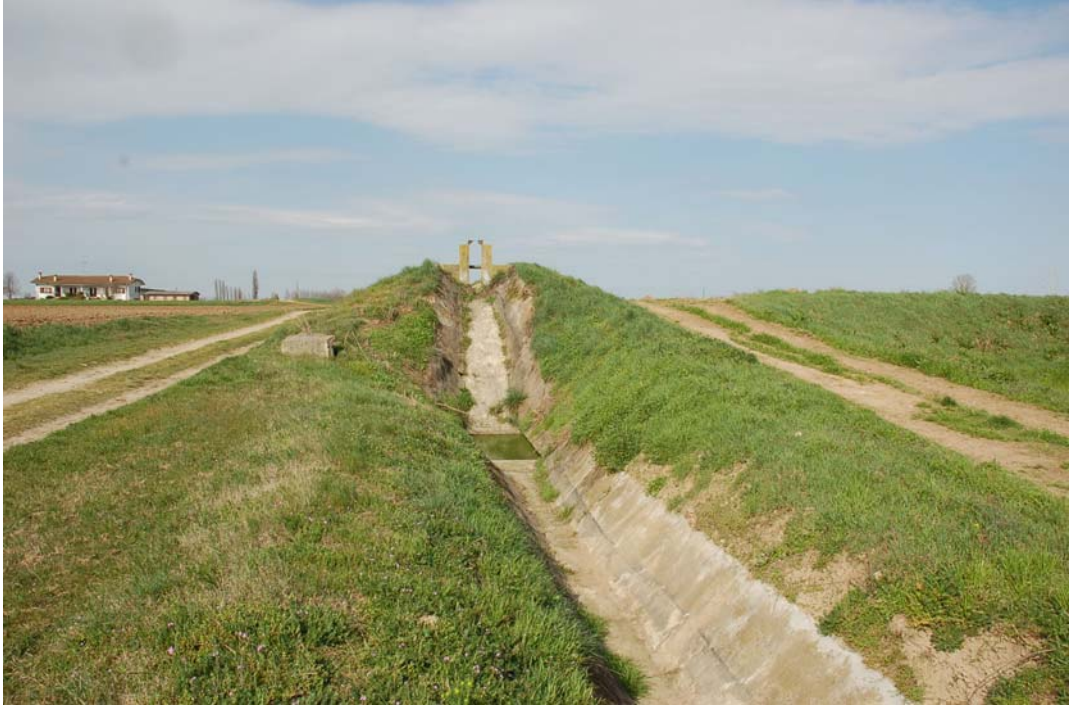
Figura 5 – (6e_N_061) – Chiusa e salto di quota della canaletta irrigua del Consorzio di Bonifica. Risulta ancora ben evidente, sulla destra, la scarpata di paleovalveo.
