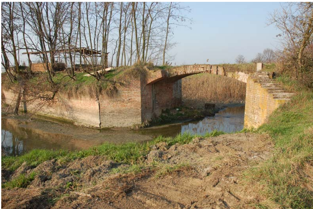
Figura 66 - (6a_N_011): L’immagine documenta i manufatti di regolazione idraulica del canale diversivo che convogliava le acque di piena a valle del Mulino Pieve.
