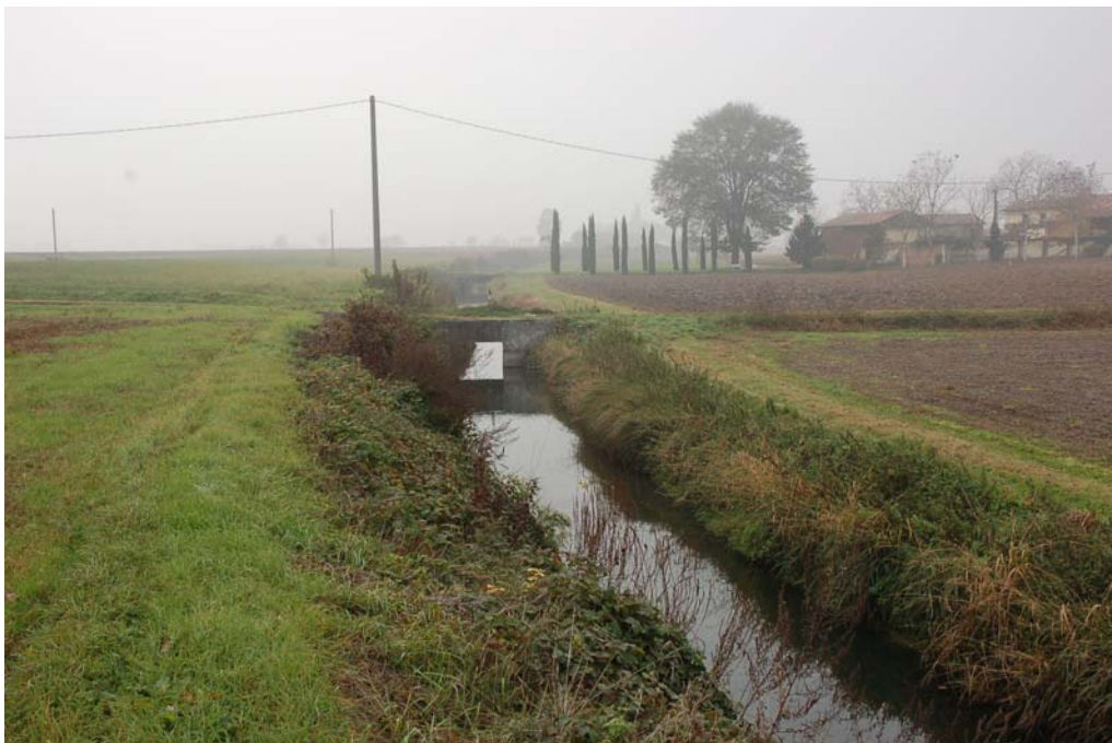
Figura 36 (5d_SW_038): Il colatore “Lame” lungo il confine con il territorio di Bozzolo, ed uno dei numerosi ponticelli che lo attraversano.; quest’ultimi sono del tutto simili tra loro e realizzati in cemento armato.
