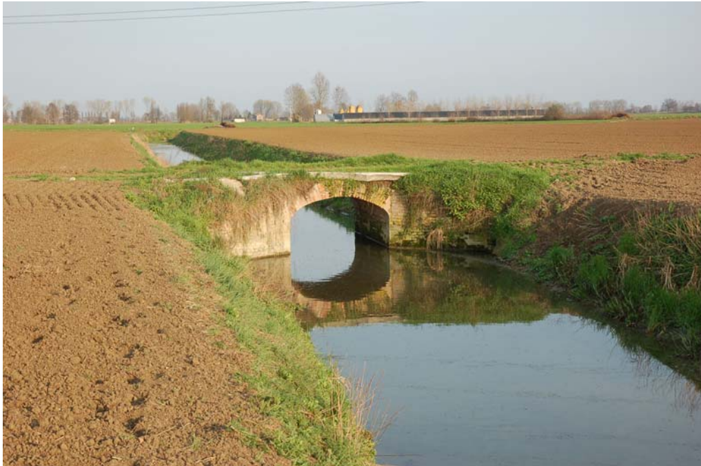
Figura 74 (7e_E_016): Il canale Delmoncello ed uno dei ponticelli in pietra posti lungo la viabilità campestre a servizio dei fondi nell'ambito in esame.
