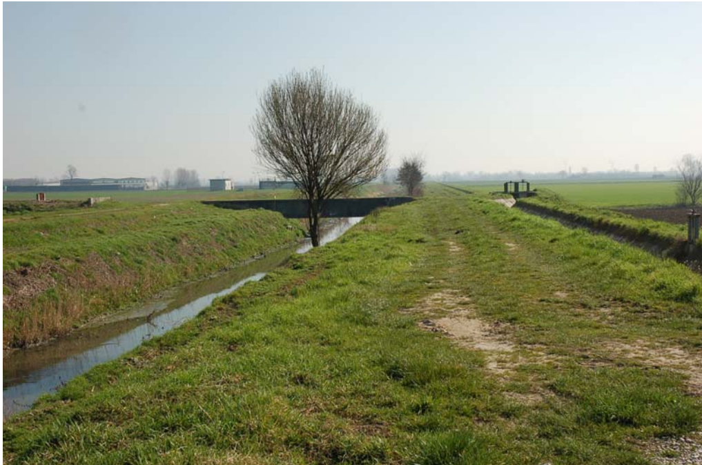
Figura 44 (6b_E_025): Un'altra immagine del canale "Riglio Delmonazza" ripreso dalla strada vicinale Pradelle, lungo il nuovo tracciato voluto dal Consorzio di Bonifica.
