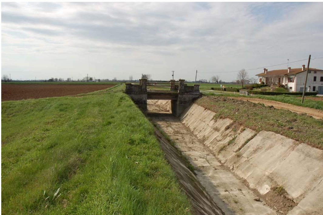
Figura 4 (6e_W_061b): Ponte sul canale di irrigazione pensile del Consorzio di Bonifica Navarolo, in fregio alla S.P. 61 "Gazzuolo - Rivarolo - San Giovanni" di Cividale.
