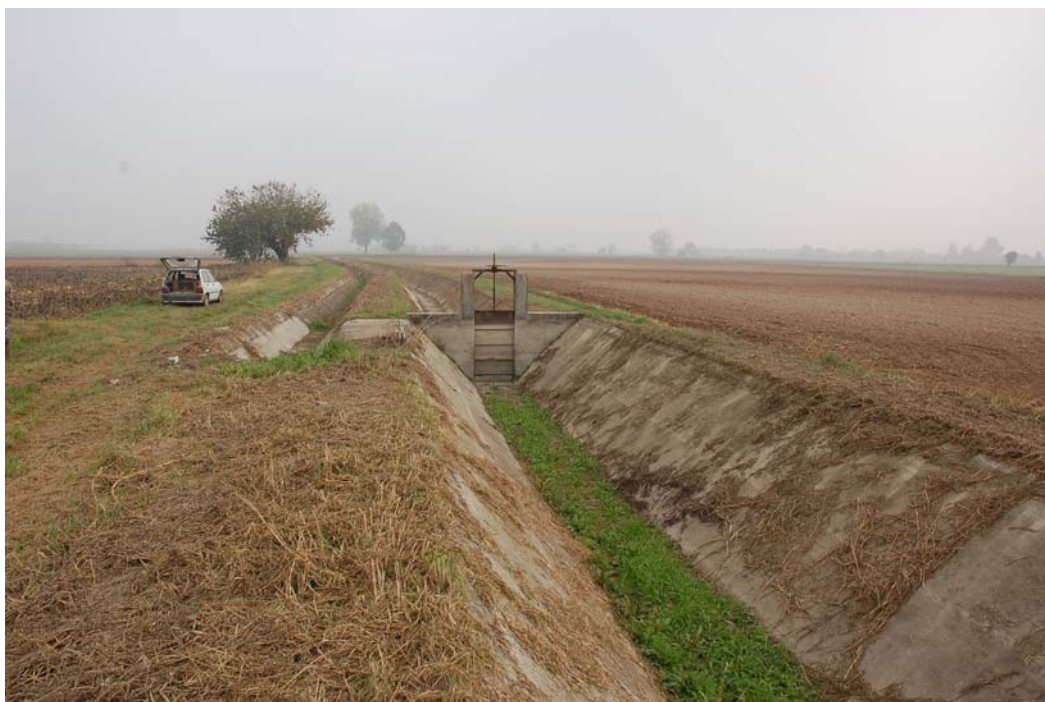
Figura 9 (5b_E_047): Canaletta irrigua con diversivo secondario e manufatto con paratia di chiusa posta sul confine tra le unità cartografiche 3 e 4.
