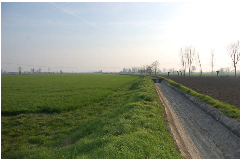
Figura 71 (7a_S_015): L'immagine documenta la canaletta irrigua del Consorzio di Bonifica posta a cavallo del confine con il territorio di Casteldidone e che convoglia verso il settore di sud ovest le acque irrigue emunte dal fiume Oglio.
