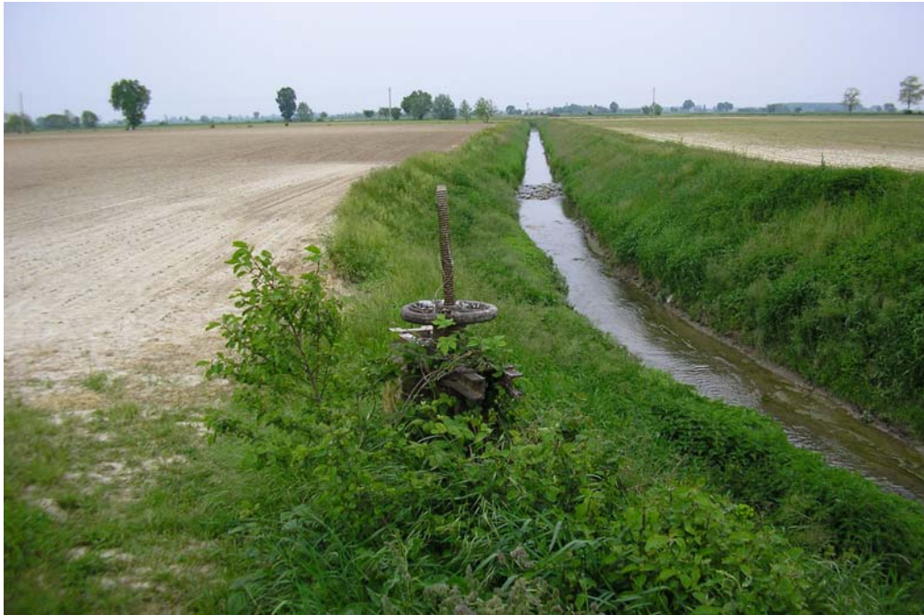
Figura 40 (2d_N_026): Il colatore Gambina superiore nella porzione a nord del canale Acque Alte. Si evince chiaramente l'opera di rettifica del tracciato originario documentato dalla figura 39, dal parte del Consorzio di Bonifica Dugali.
