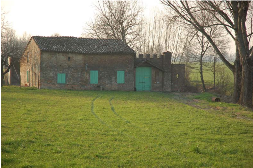
Figura 65 (6a_W_023): Ciò che resta del mulino “della Pieve”, ripreso dal ponte lungo il canale Riglio Delmonazza. L’edificio non riporta più nessun segno delle originarie strutture che convogliavano le acque lungo le pale delle macine.
