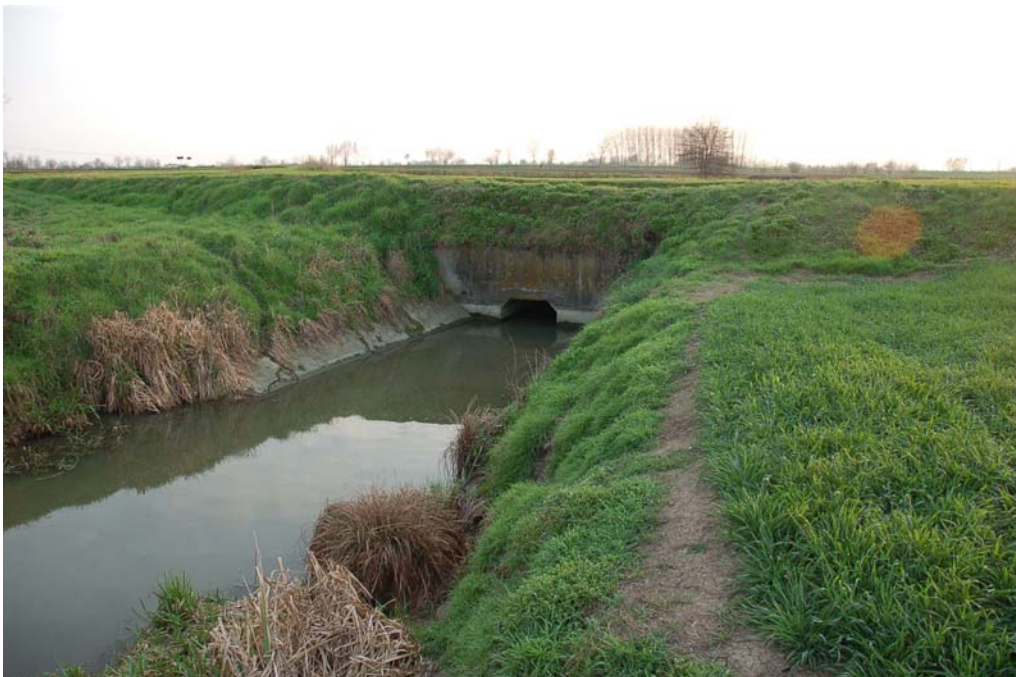
Figura 64 - (7d_SW_026): L’interessante “incrocio” idraulico tra il canale Delmoncello, documentato dall’immagine, che attraversa, mediante sifone, il colatore “Gambina”.
