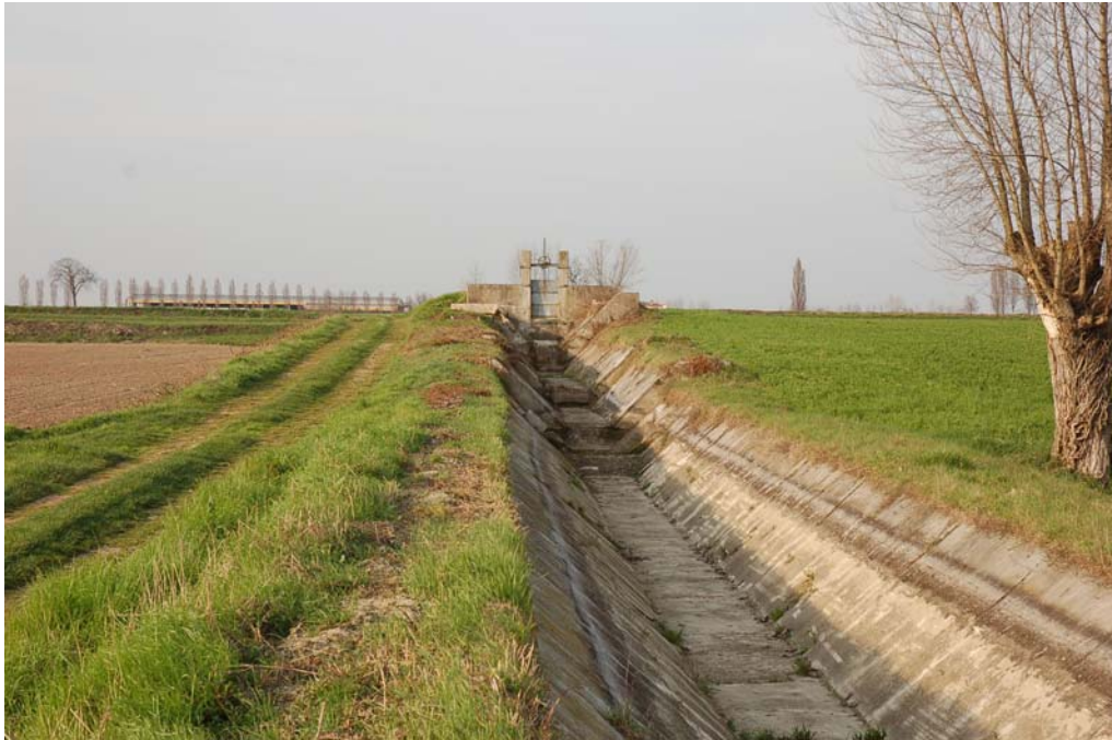
Figura 72 (6e_N_007): Il salto della canaletta irrigua del Consorzio di Bonifica, in corrispondenza della scarpata di paleoalveo.
