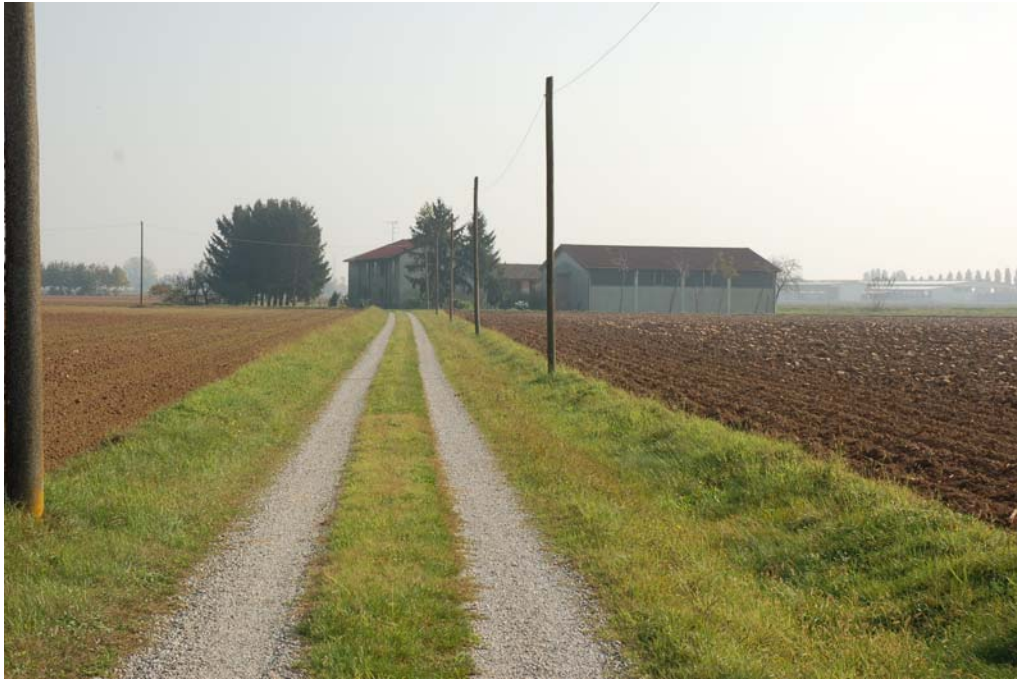
Figura 23 (5b_E_010): La cascina “Castellana”, unico edificato all’interno dell’unità cartografica. Già documentata dal catasto teresiano è stata, in anni relativamente recenti, integrata con fabbricati agricoli in elementi prefabbricati.
