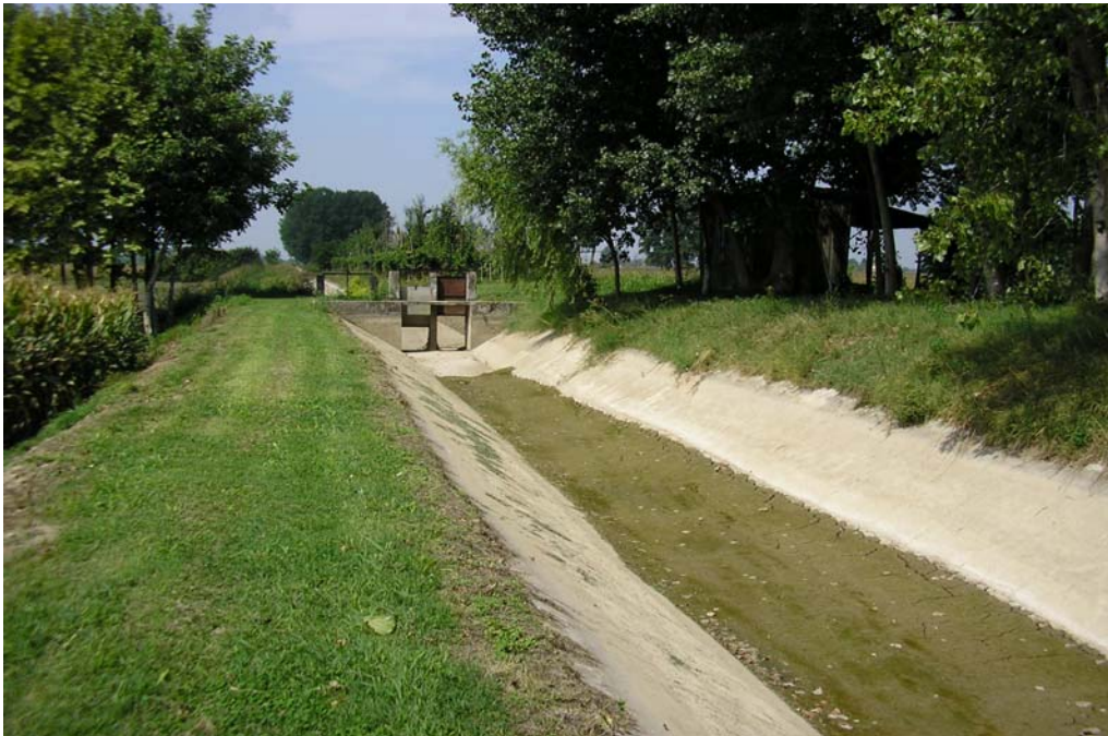
Figura 28 - (4b_W_029): La canaletta di irrigazione del consorzio di Bonifica Navarolo parallela al canale Acque Alte, lato destro, con le chiuse di regolazione.
