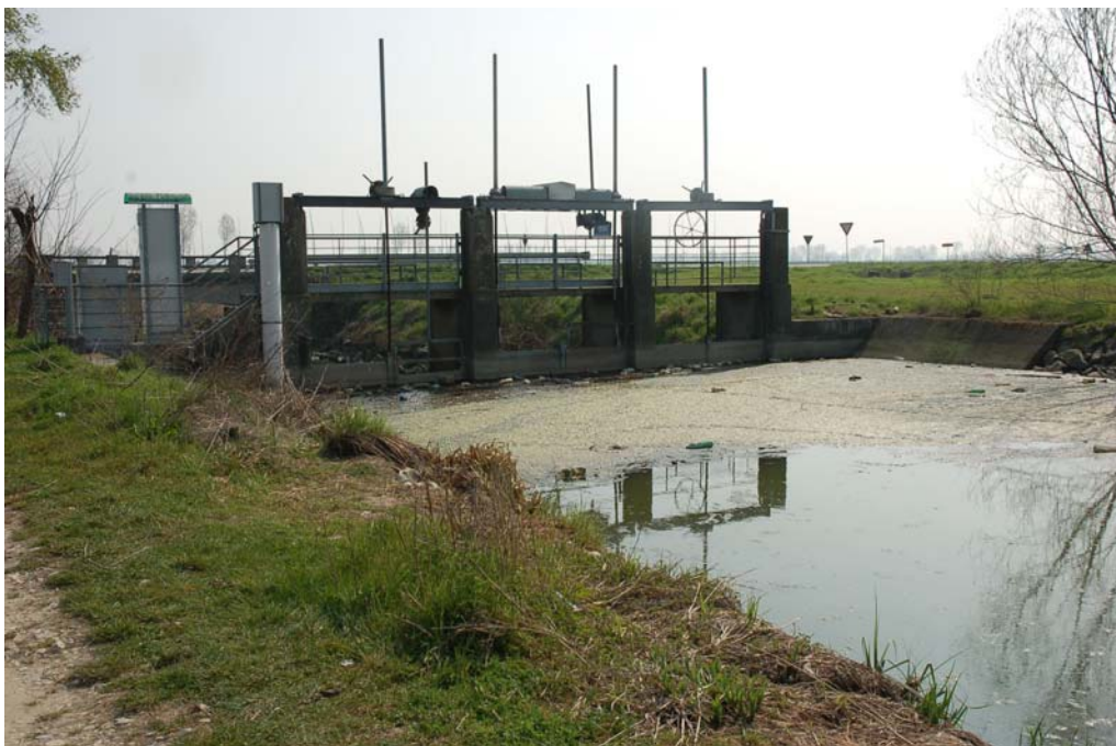
Figura 56 - (9b_E_030): Le chiuse di regolazione idraulica lungo il canale Navarolo, subito a monte del ponte della Strada Provinciale n° 64 "Bozzolo - Casalmaggiore", in confine con il territorio cremonese di Rivarolo del Re ed Uniti.
