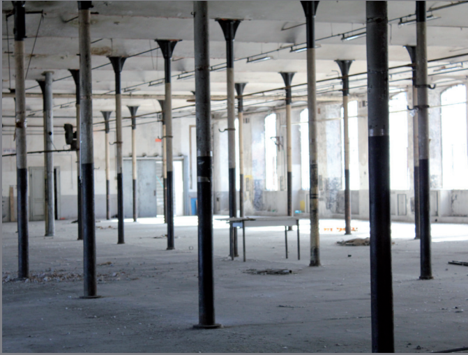
Immagine_26_Interno piano secondo, 2010, ben visibile la ripetizione delle colonne in ghisa che scandisce l'ambiente.
