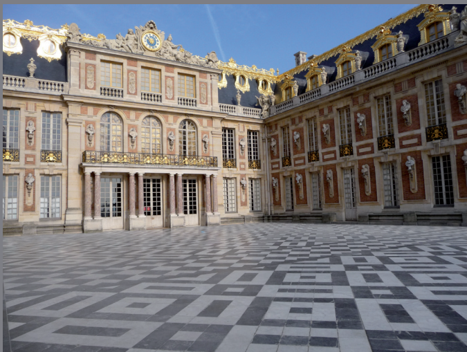
Immagine_11_Cour de Marbre, aspetto attuale della facciata dell'originale palazzina di caccia.
