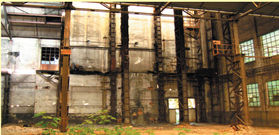
Fig.47- L'interno della fabbrica prima della riqualificazione
