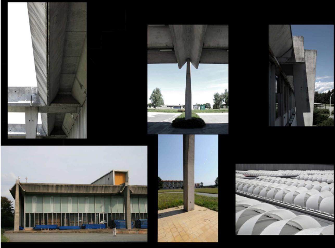
Fig.32-33 - Condizioni attuali della struttura dello stabilimento
