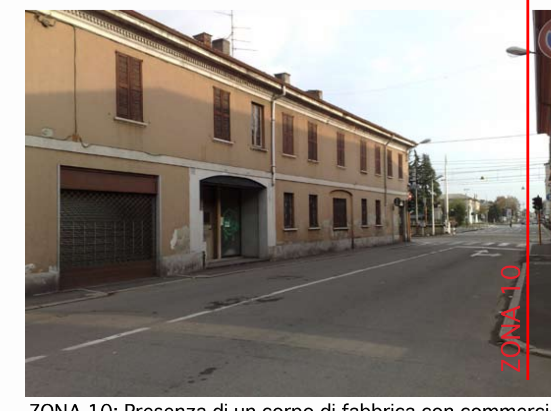
ZONA 10: Presenza di un corpo di fabbrica con commercio al piede attualmente dismesso. Affaccio principale sulla Strada Provinciale e nelle vicinanze della Stazione e della Ferrovia
