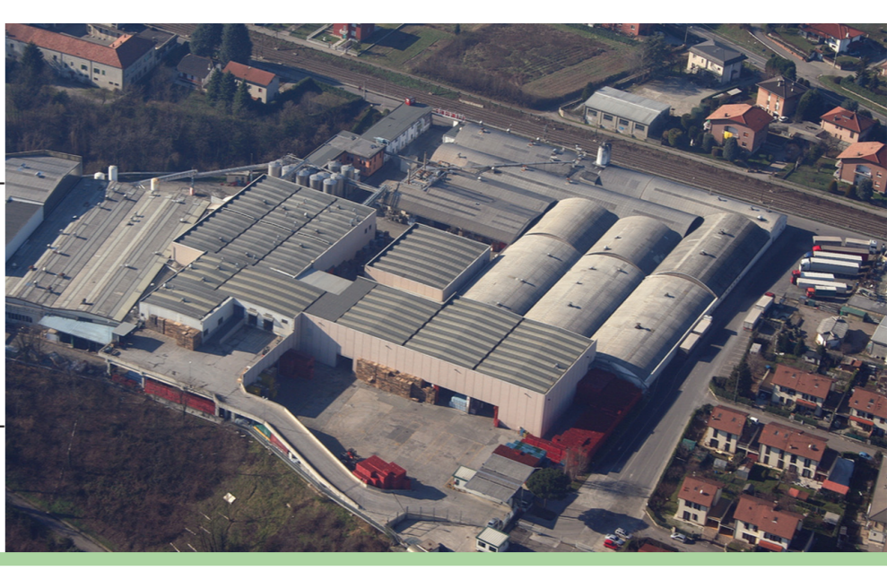
07. Calvasi CP spa, produzione di decori natalizi, recentemente demolita, saranno edificati sei edifici residenziali per un totale di 76.000mq.
