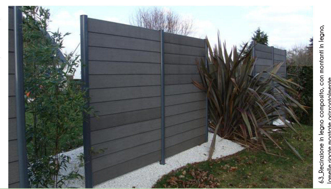
63. Recinzione in legno composito, con montanti in legno, lamine rigate sovrapposte orizzontalmente.
