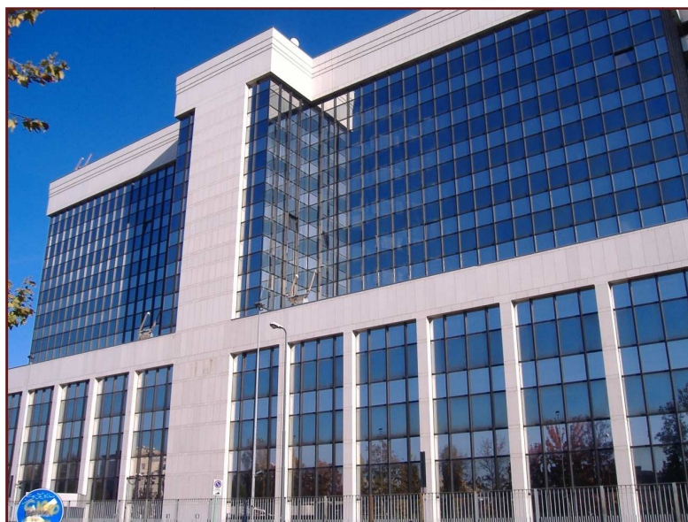
Figura 23: immobile Sant'Elia - facciata esterna (rilievo fotografico dell'autore)
