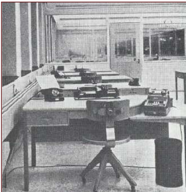
Figura 52: Thule Husset, Stoccolma - interni
