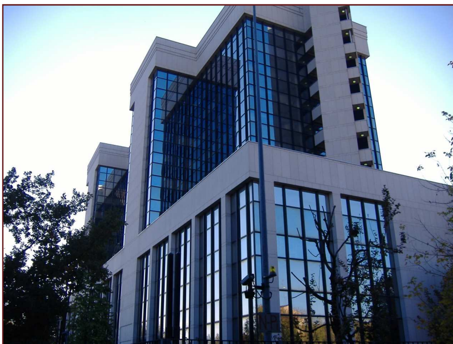
Figura 20: Immobile Sant'Elia - vista esterni (rilievo fotografico dell'autore)
