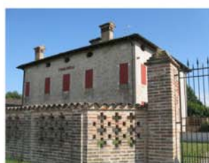
Corte ristrutturata tra S.Martino e S.Girolamo
