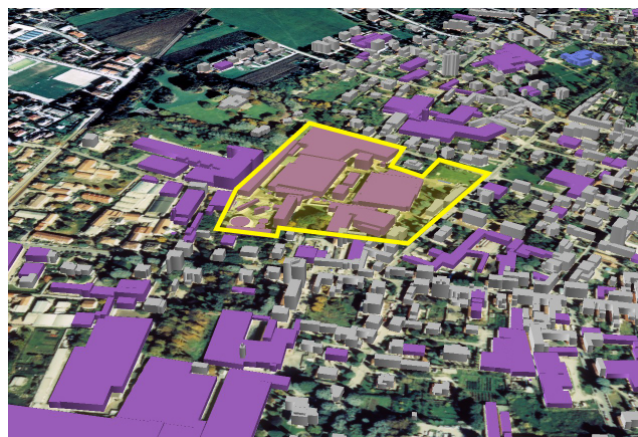
La Tpb vista da ovest verso est
