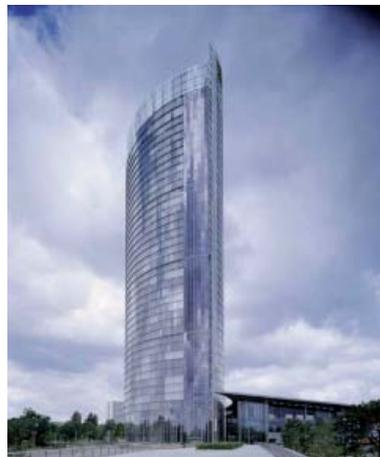
Si tratta di un edificio particolarmente interessante per l'applicazione di numerose tecnologie all'avanguardia, quali l'attivazione della massa, l'involucro a doppia pelle con particolari accorgimenti geometrici, un sistema di ventilazione di naturale e l'inserimento di skygarden.
