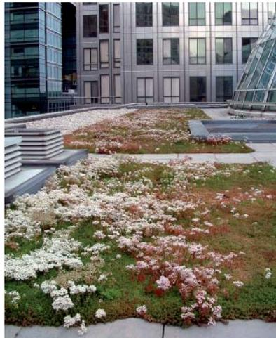
Uno spessore fine, tra i 2cm ed i 3cm, può prevedere la presenza di soli muschi e sedum, una vegetazione dai bisogni idrici estremamente limitati. Le piante succulente si adattano bene a questa condizione, potendo resistere a condizioni di calore e siccità estreme grazie all'assenza di traspirazione (dovuta al CAM, Crasulacean Acid Metabolism), attivata solamente durante la notte.
