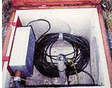
Figura 32: Testa di un tubo piezometrico attrezzato con sensori di livello
