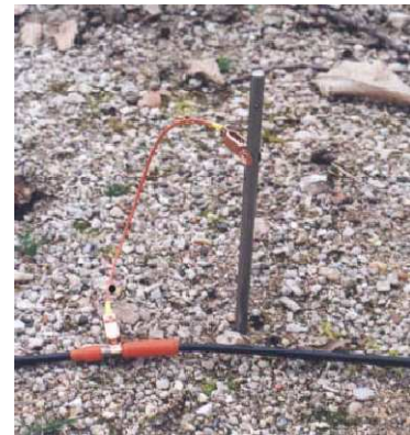
Figura 6: Esecuzione della prova.
