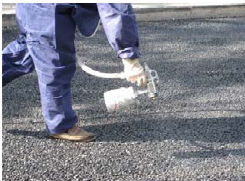
Figura 7 - Applicazione in sito di materiali fotocatalitici tramite spruzzatura
