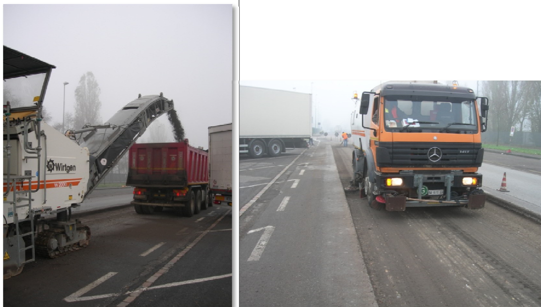
Figura 25 - fase di fresatura, pulizia
