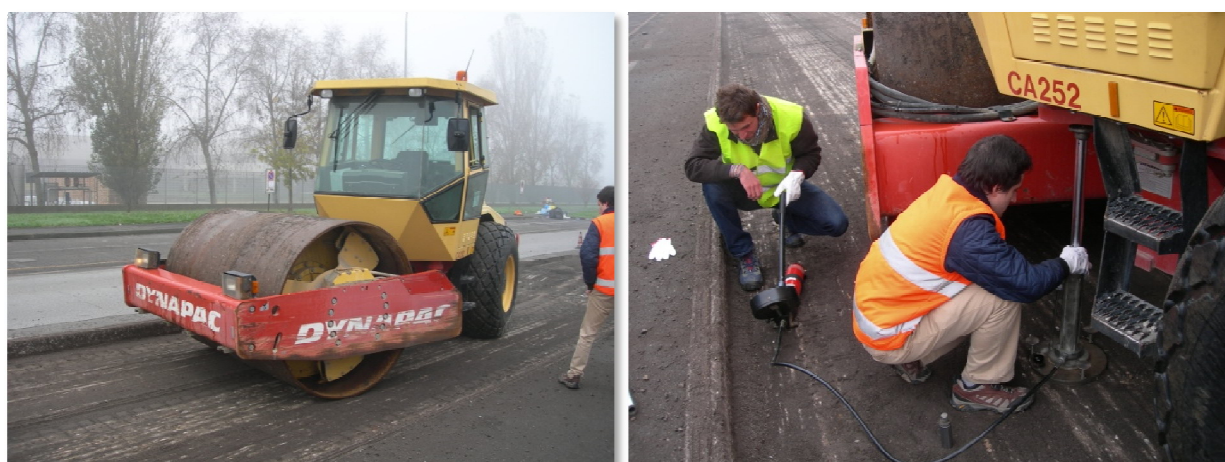
Figura 26 - prova di carico su piastra
