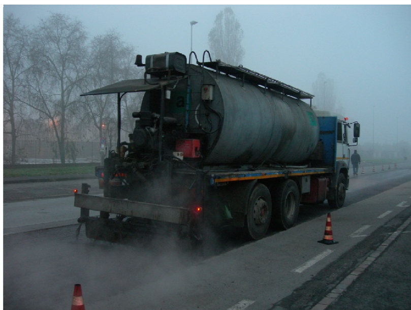
Figura 33 - stesura della mano d'attacco
