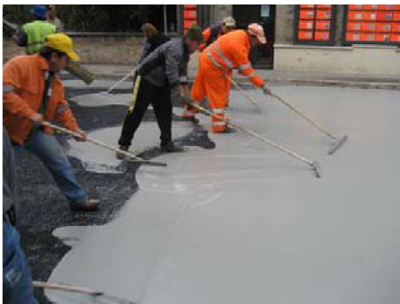
Figura 8 - applicazione in sito di materiali fotocatalitici con malte cementizie fotocatalitiche
