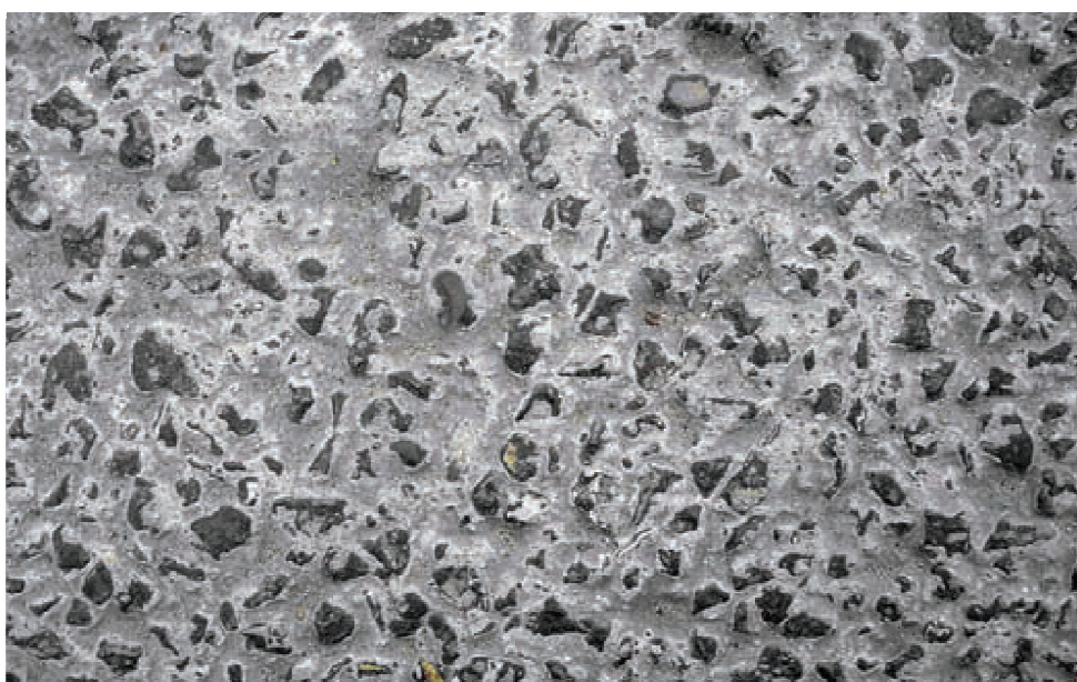
Figura 10 - superficie di pavimentazione fotocatalitica usurata da pneumatici
