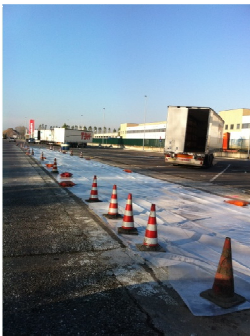
Figura 39 - copertura della pavimentazione
