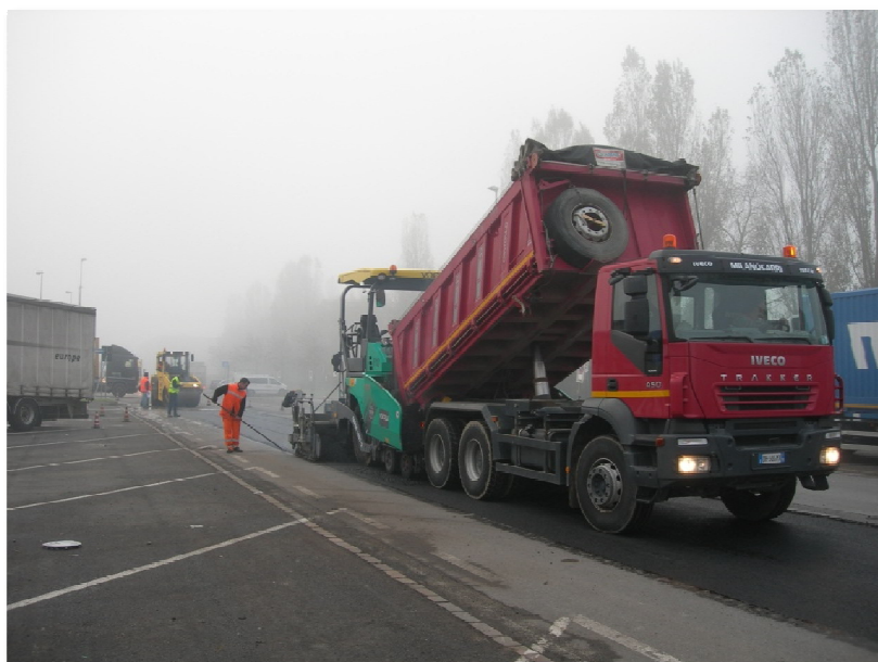
Figura 34 - stesura e rullaggio dello strato di usura
