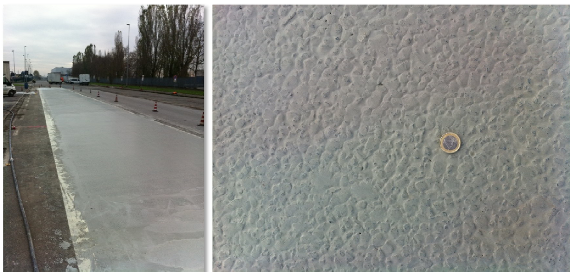
Figura 38 - strato d'usura intasato
