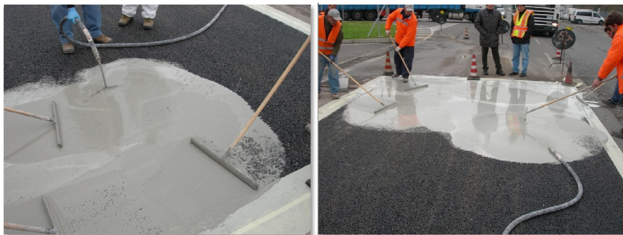
Figura 37 - intasamento dello strato d'usura e lavorazione mediante raclee
