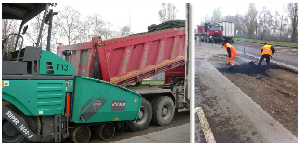
Figura 27 - stesa dello strato di base
