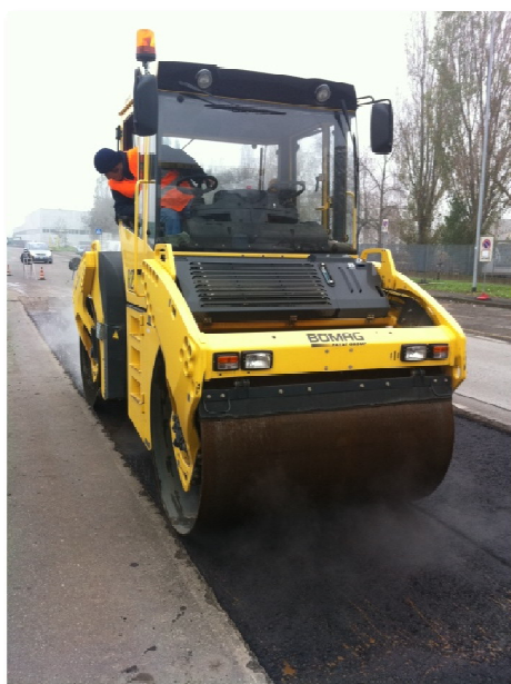
Figura 29 - fase di compattazione
