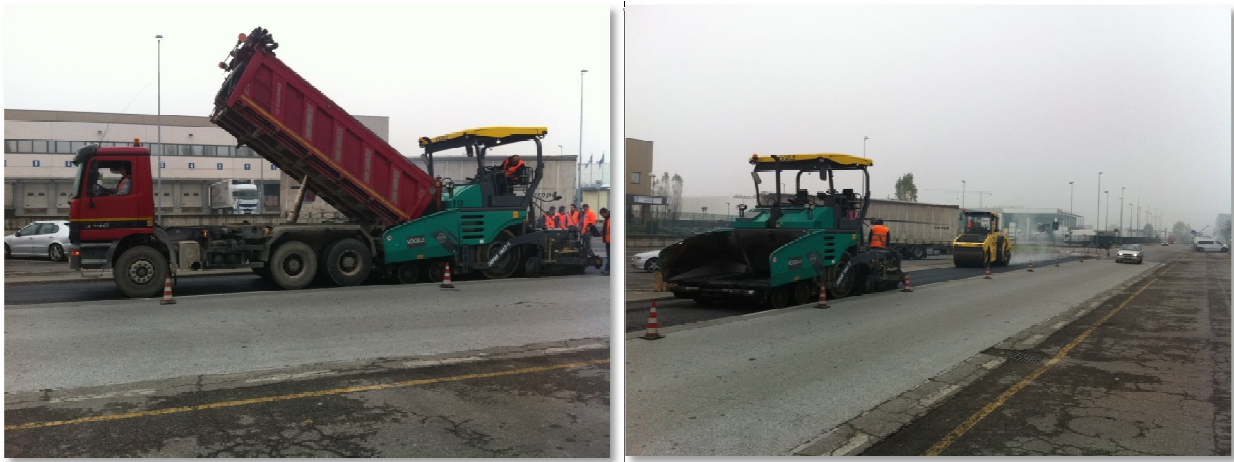
Figura 32 - fase di stesa dello strato di binder
