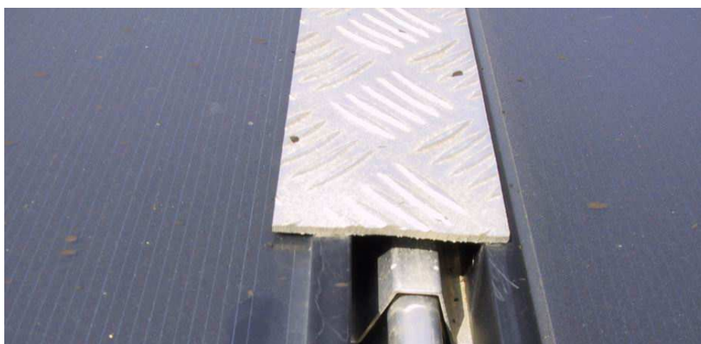
Figura 5.4 - Ombreggiamento per sovrapposizione di profilati su alcuni moduli
