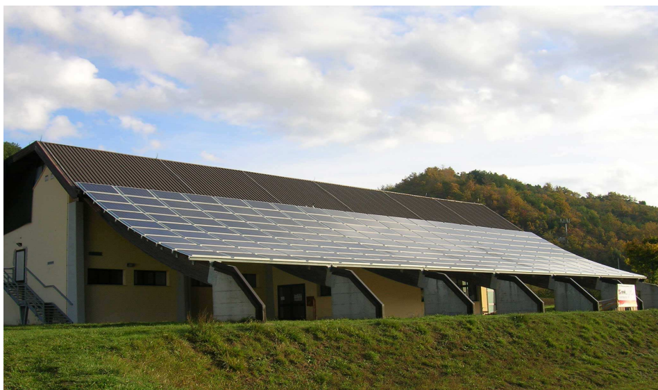
Figura 4.18 – Impianto a struttura fissa installato nel centro Italia.
