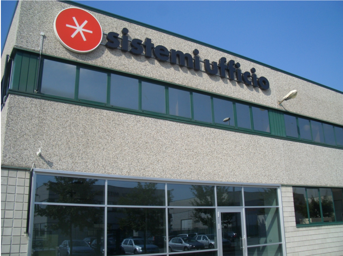
Fig. 3.13 New site in Lurago Marinone, via della Cerca 20
