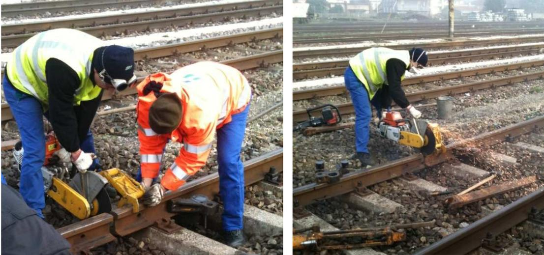
*Figura 6.17 – Realizzazione del taglio della rotaia*
