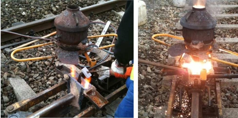
*Figura 6.24 – Operazione di saldatura alluminotermica*
