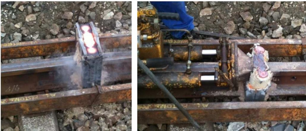
*Figura 6.25 – Rimozione dei residui di saldatura*
