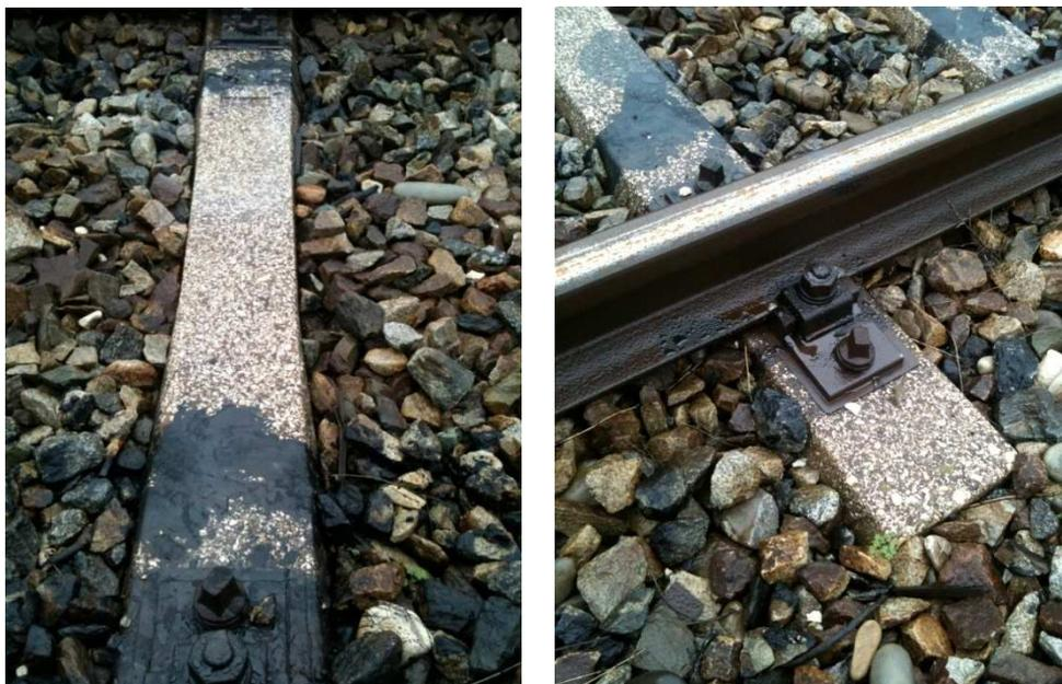
*Figura 6.3 – Particolare delle traverse in ca.p. e dell'attacco tipo k del binario di prova*
