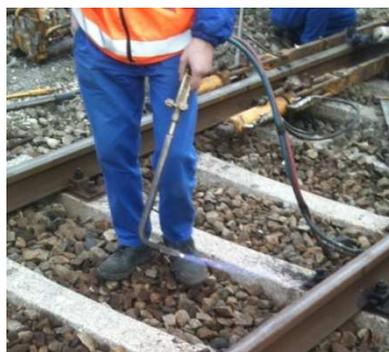
*Figura 6.27 – Riscaldamento della rotaia con cannello*
