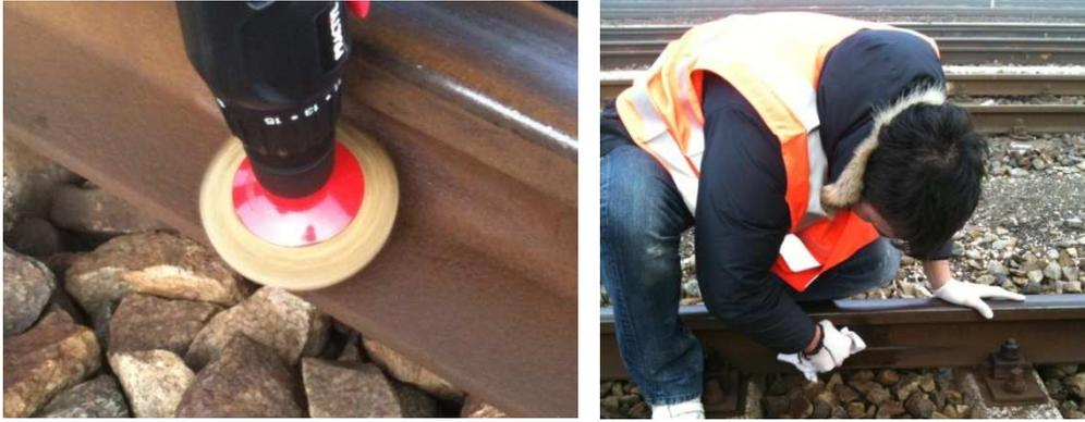
*Figura 6.10 – Preparazione della superficie del gambo*
