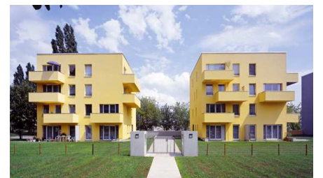
Vista laterale dopo l'intervento
