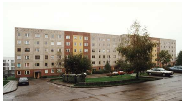
Vista della facciata prima dell'intervento
