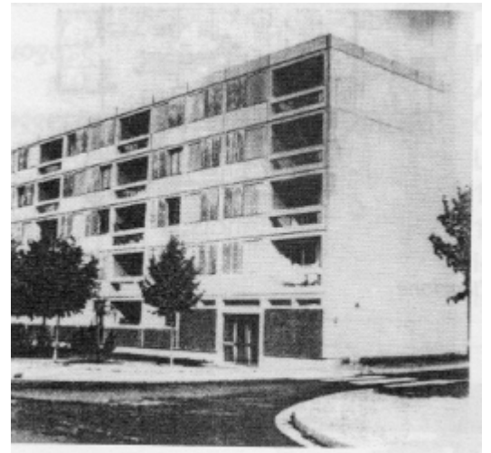
Vista dell'edificio prima dell'intervento
