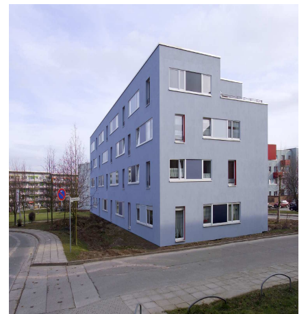
Vista della facciata dopo l'intervento
