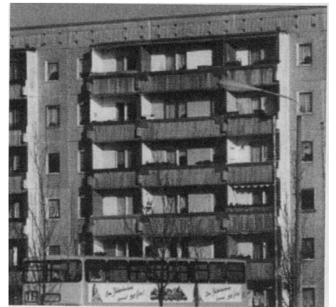
Vista della facciata prima dell'intervento
