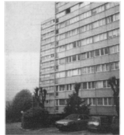
Vista dell'edificio prima dell'intervento
