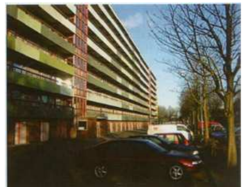
Stato di fatto fronte con i ballatoi
