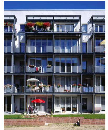
Vista della facciata dopo l'intervento
