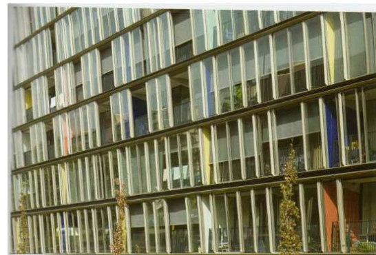
Dettaglio della facciata che evidenzia l'inclinazione dei vetri e la variazione cromatica dei divisori.
