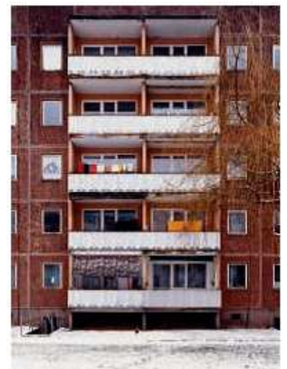
Vista della facciata prima dell'intervento
