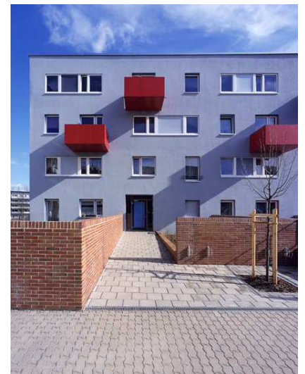
Vista della facciata sul retro dopo l'intervento
