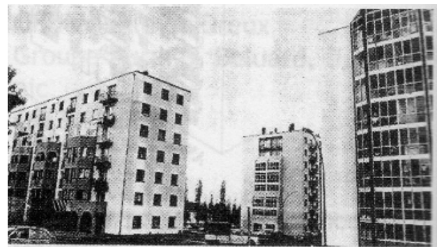
Viste degli edifici
