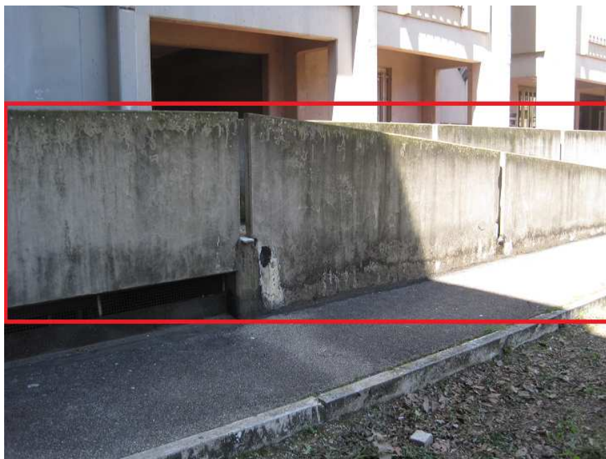
Immagine 3.14 Colonizzazione biologica parapetto piano terra
