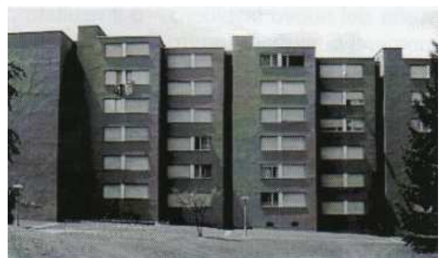
Edificio in linea prima dell'intervento
