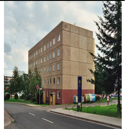
Vista della facciata prima dell'intervento
