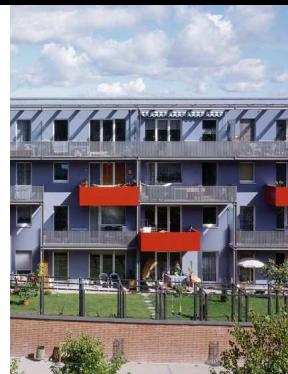
Vista della facciata dopo l'intervento
