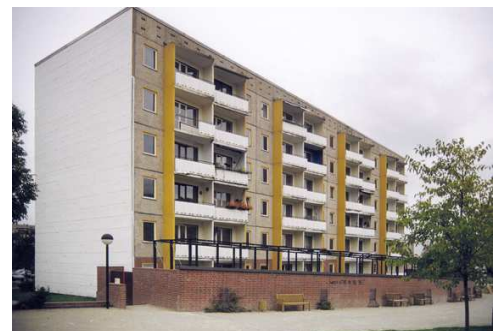
Vista della facciata sul retro prima dell'intervento
