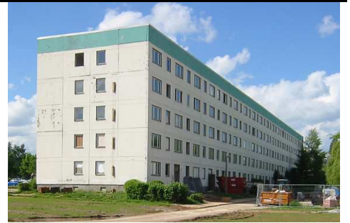
Vista del complesso prima dell'intervento
