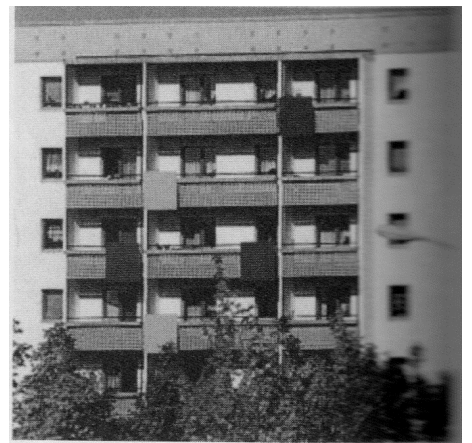
Vista della facciata dopo l'intervento
