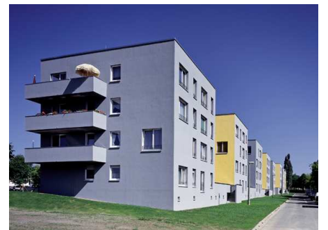
Vista della facciata dopo l'intervento
