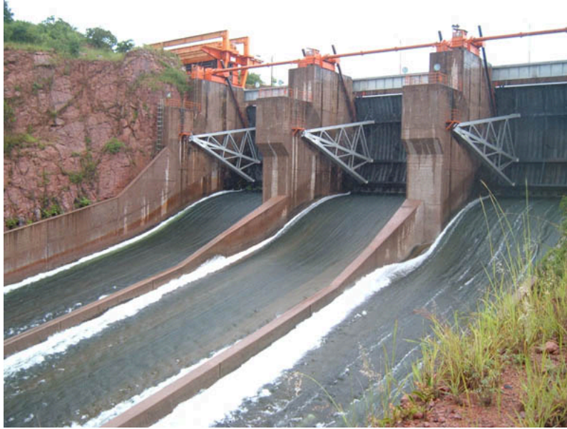
Figura 3.8: Sfiatore principale del serbatoio di Itezhi-tezhi.
