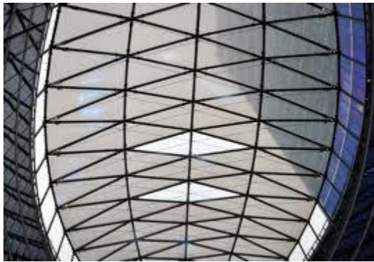
Figura 5.5.1 Copertura inquadrata dalla piazza sottostante
