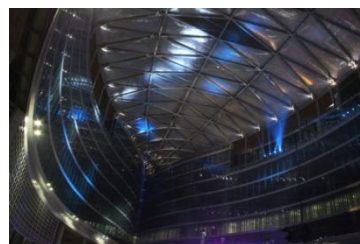
Figura 4.2.2 immagine della copertura ripresa dalla piazza
