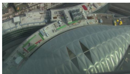
Figura 4.2.3 Immagine della struttura ripresa dall'alto
