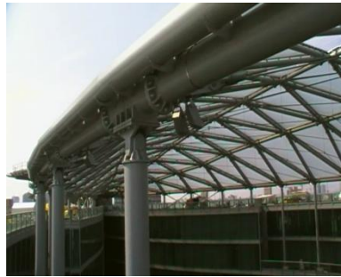
Figura 4.2.1 vista laterale della struttura
