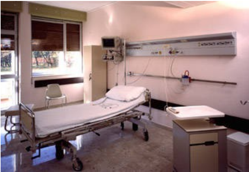
Fig.: Esempi di posto letti da UTI con trave di servizio a soffitto e trave di servizio da parete
